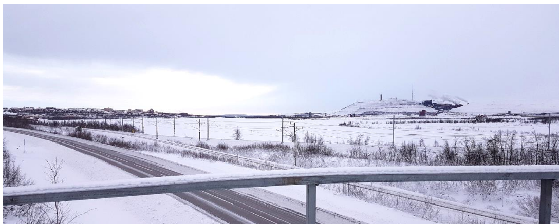
Vy från viadukten i område A mot Kiruna och gruvan.
