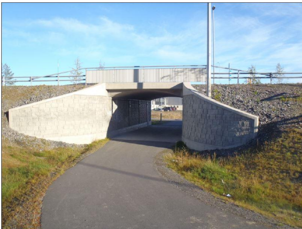
Figur 18. Exempel på gång- och cykelpassage av betong
