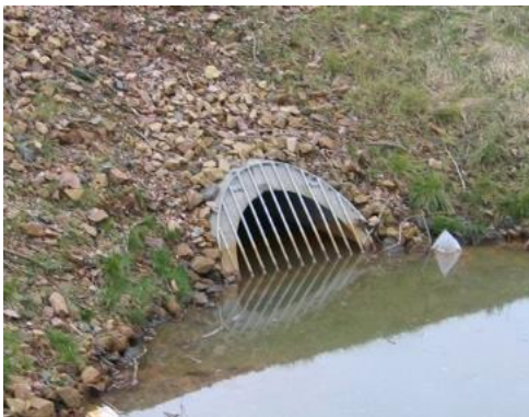
Figur 6. Exempel på snedkapad trumma och trumöga.
