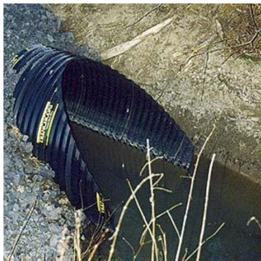
Figur 6. Exempel på snedkapad trumma och trumöga.
