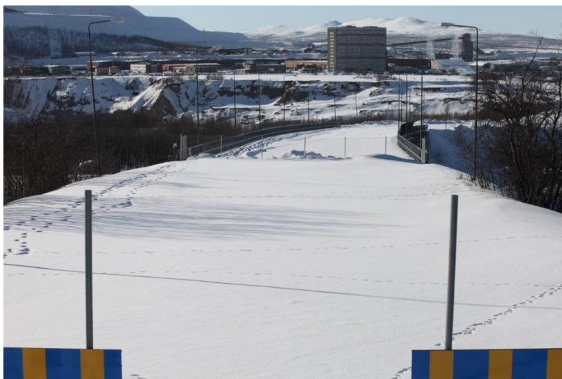
Figur 1 Redan idag påverkas vägarna i Kiruna av markdeformationerna och hösten 2013 stängdes bron över E10, Gruvvägen.
