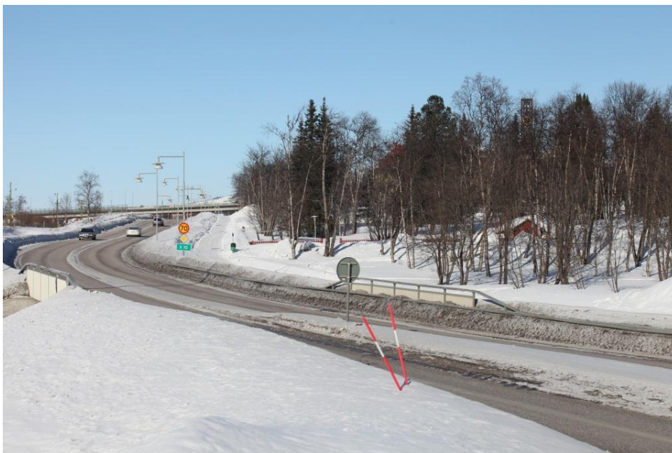
Figur 14 Vy över gruvstadsparken och början på omläggning av vägen.
