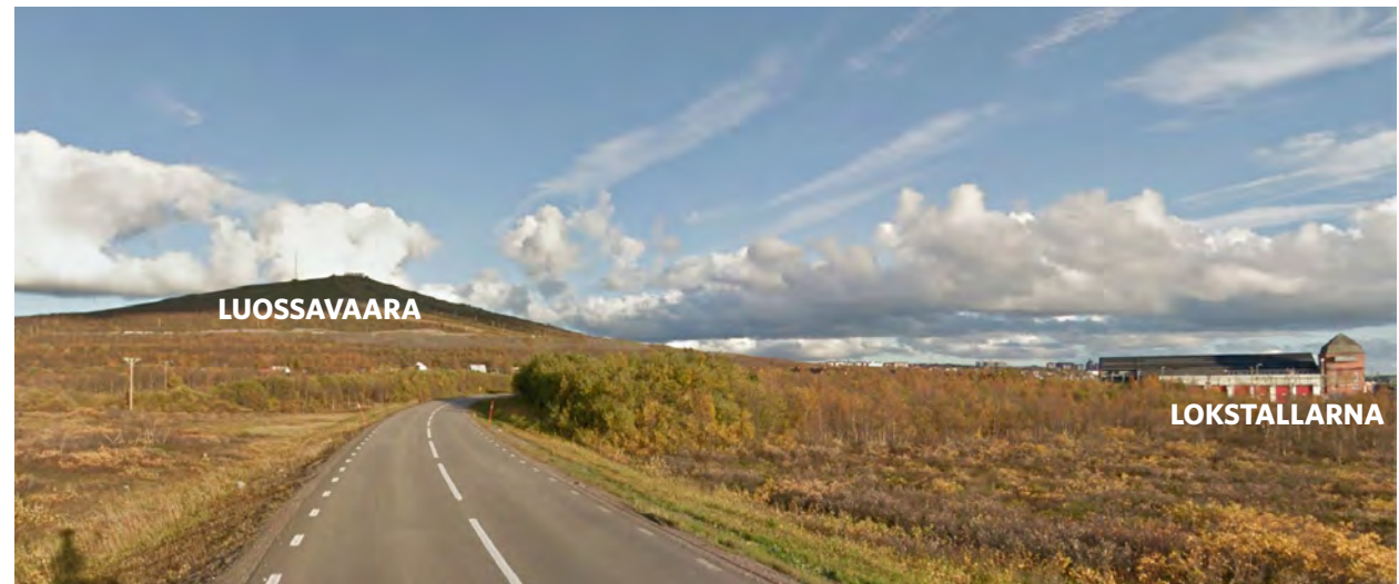
Figur 5.4. Berget Luossavaara sedd från väster och lokstallarna till höger i bild.
