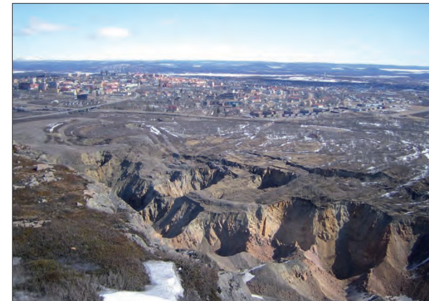
Figur 1.1.2: Fotot visar deformation av marken närmast Kiirunavaara. Kratrarna är tydliga tecken på en långt framskriden deformation.
