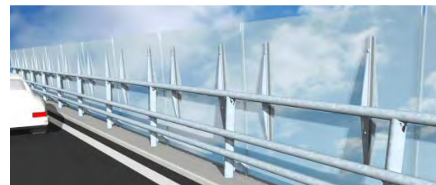
Fig 5.9. Förebild - genomskinliga bullerskärmar vid väg. Bild fabrikat System Safeline.
