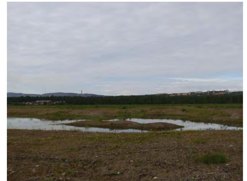
Figur 3.4. F d sedimentationsdamm. Vy över staden och Kirunavaara.
