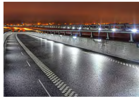
Figur 6.10. Partihallsbron i Göteborg - ljussättning körbana
