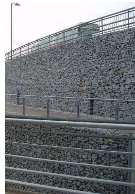
Figur 6.21. Förebild gabionmur. Arlanda.
