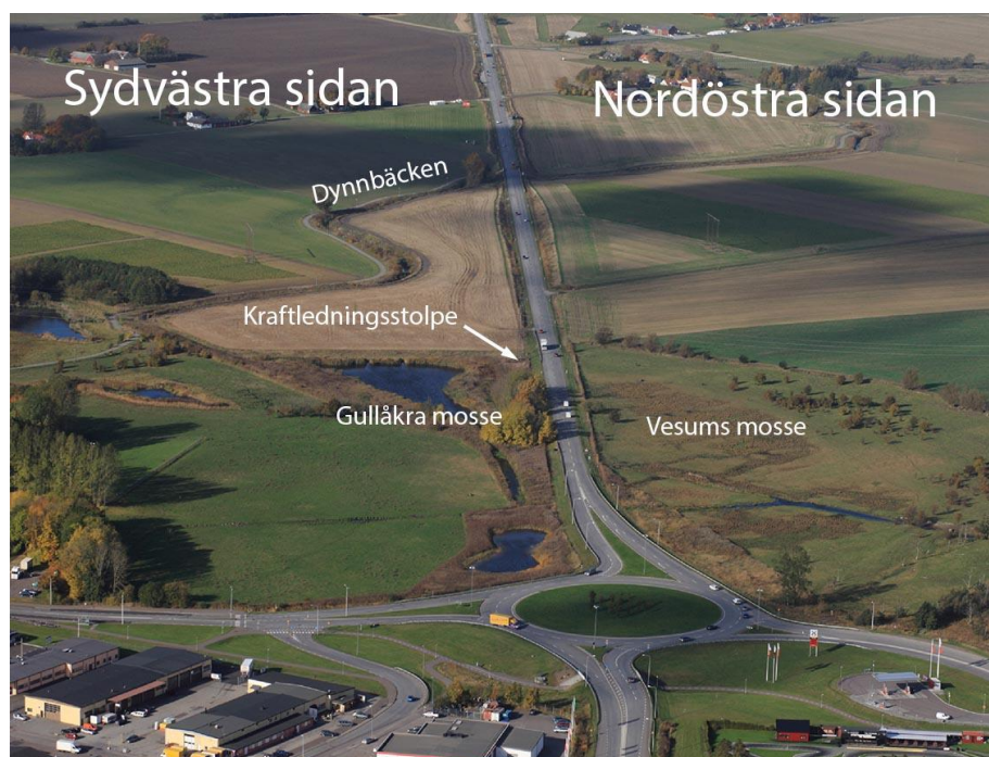
Figur 9 - Översikt över väg 108 i riktning mot Lund och med cirkulationsplatsen vid Gullåkra i förgrunden.
