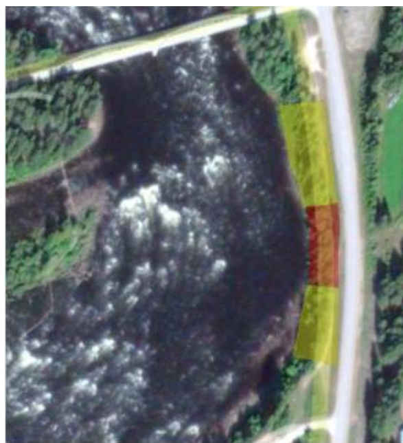
Figur 4–2. Bedömt behov av utökat erosionsskydd, röd del bedöms vara mer akut.
