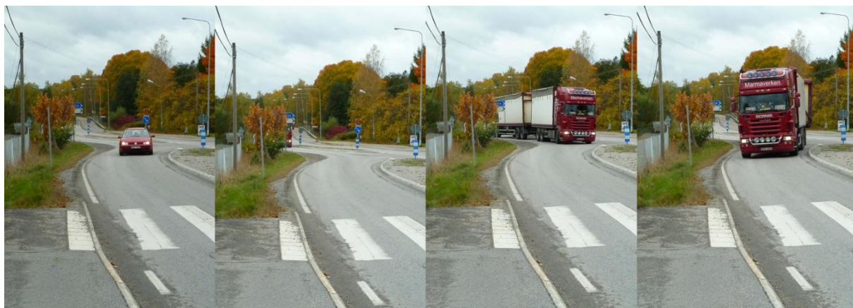
Figur 10. Sikten vid övergångstället tvärs väg 57 vid Snickarvägen är helt skymd av tre unga träd i tätortsporten samt av vägskyltar.
