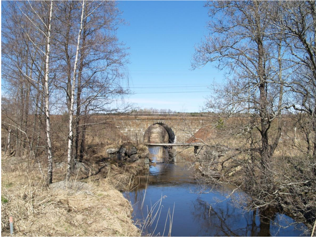
Figur 20 Befintlig järnvägsbro, Västra stambanan. Fotot är taget på tidig vår och än syns bron tydligt. När grönskan är tät skymms bron från vägen sett. Föreslagen gallring för att förstärka såväl bro som vattendrag.
