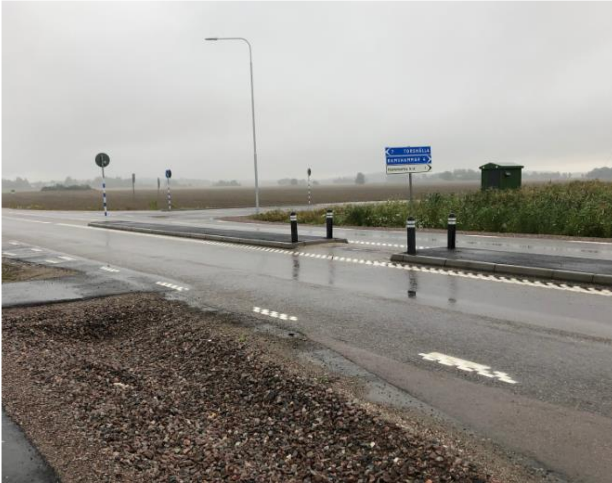
Figur 3. Refuger på väg 953 byggda år 2019. Foto taget från gång- och cykelbana byggd året innan.
