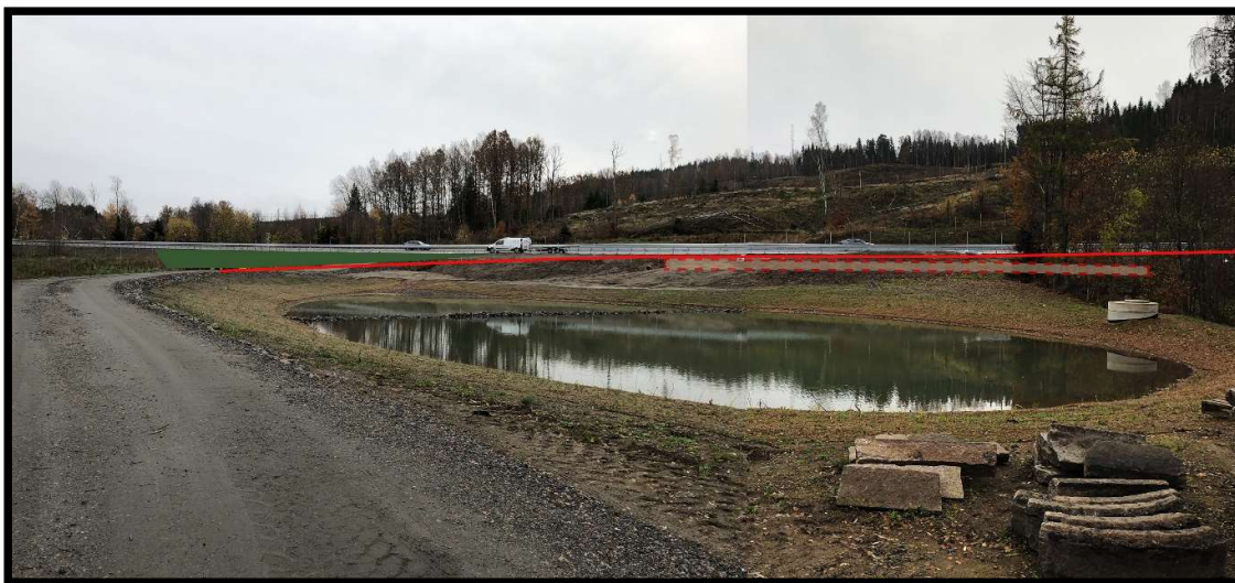
Figur 35. Gång- och cykelvägen ansluter till Kärrbogärdevägen vid dagvattendammen, se dragning i röd linje. Stödmur för gång- och cykelvägen kan antingen avslutas innanför trädridån eller vid dagvattentrumman, stödmuren illustreras i röstreckad ruta. Om stödmuren utförs som en gabionmur kan den bidra till bra landskapsanpassning som ger anläggningen en gestaltningsmässig koppling till stenmurar vid Kärrbogärdevägen. Foto: Mika Määttä, AFRY
