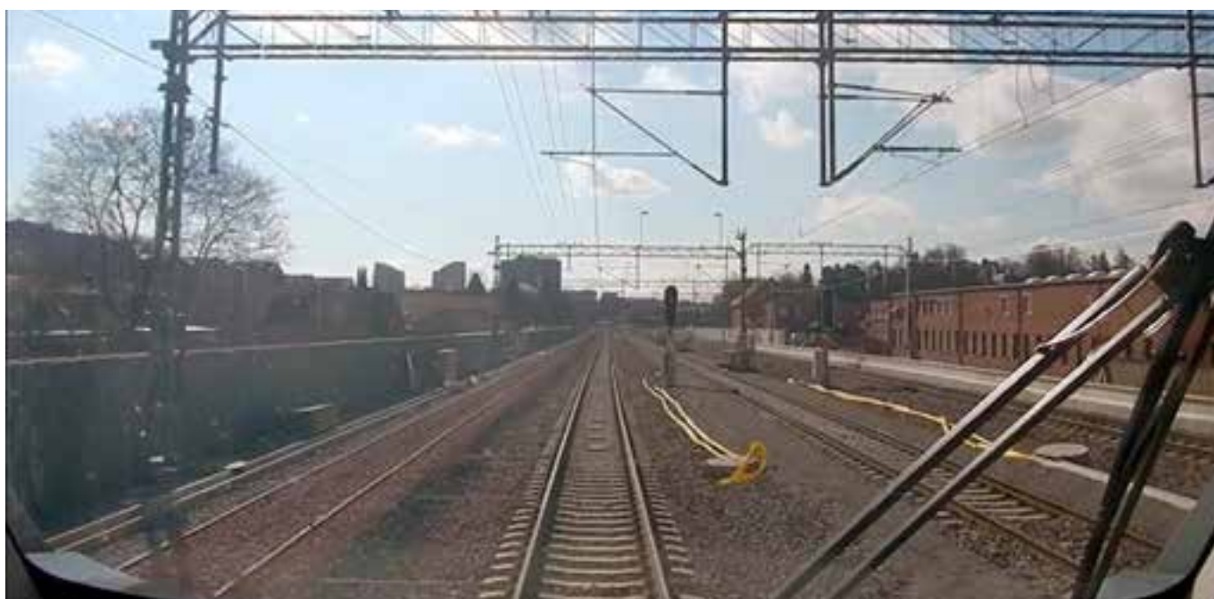
Bild 10 Aktuell placering av Jkb 21, med blivande ytterspår till vänster samt spår M till höger
