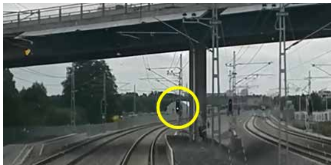
Bild 4 Visar en signal i Barkarby (Bkb 23, inringad) som hamnade bakom en pelare i högerkurva vilket innebär att det är svårt att på håll se signalen, se
