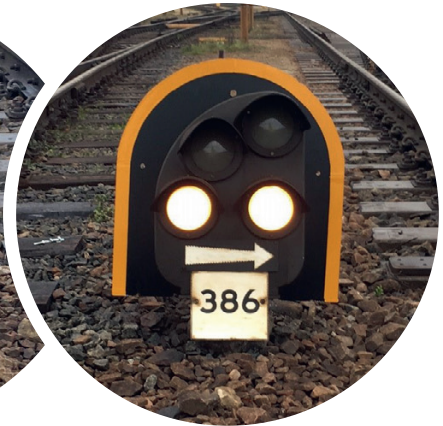
Signalen efter åtgärd (även rengjord).
