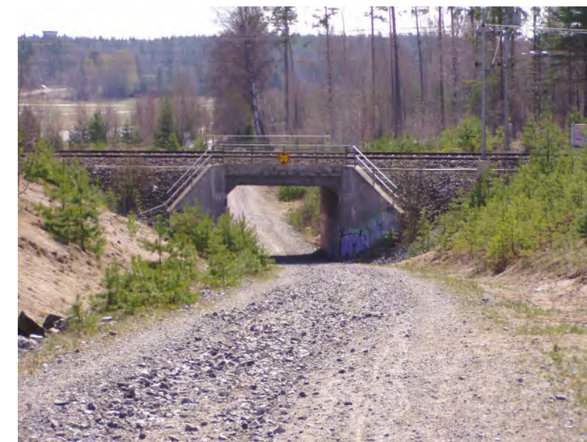
Vägport under Grödingebanan vid Riksten
