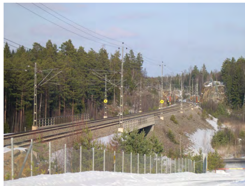
Järnvägsbro över Flottiljvägen
