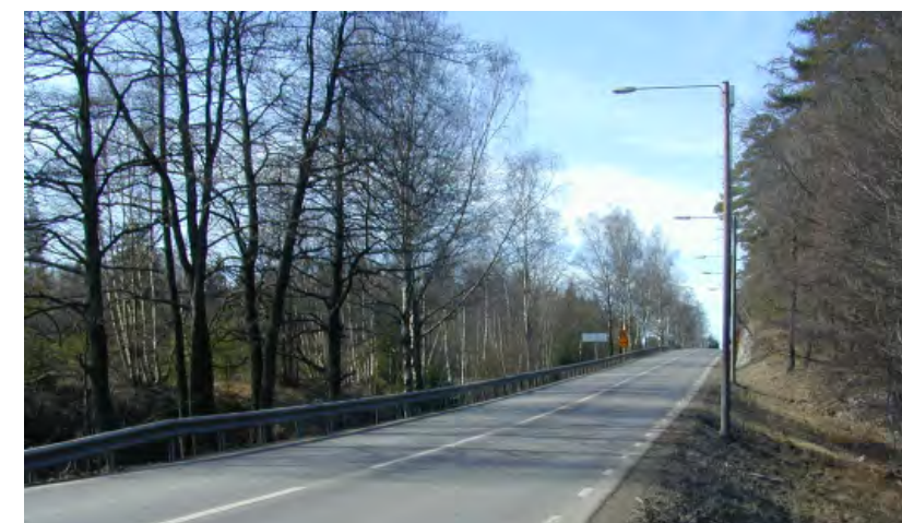
Befintlig väg Hantverksbyn, 4-fälts väg och cykelbana i förbättringsalternativet medför avsmalnat grönstråk mot pendeltågsspåret.
