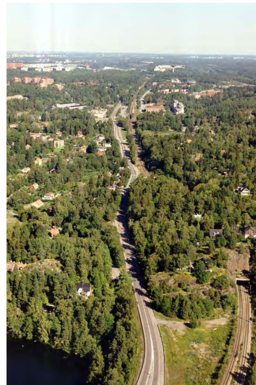
Den befintliga vägen sedd från Tullingsjön mot Tullinge centrum. Villaområdena är lummiga och vegetationen går ända ut till väggkanten.
