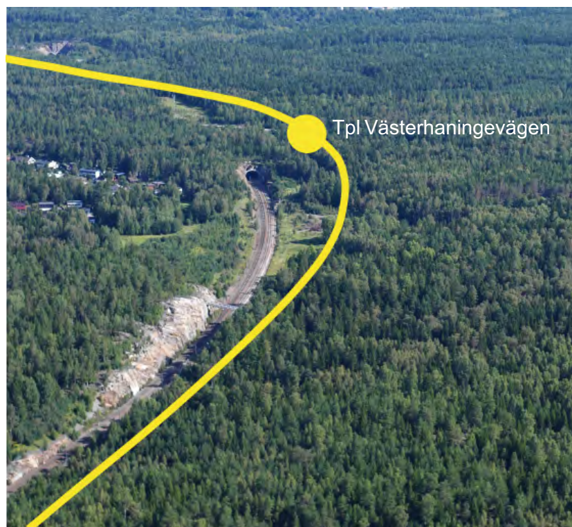
Flygbild från Riksten längs Grödingebanan mot Västerhaningevägen. Förbifartsalternativen är inritad. Väglinjen följer Grödingebanan och ger litet intrång i Hanvedens skogsområden.
