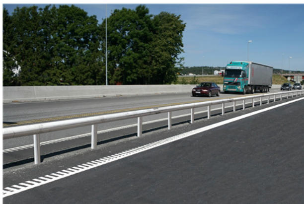
Exempel på ett mitträcke i rundad stål balkstyp. Foto: Vik Ørsta
