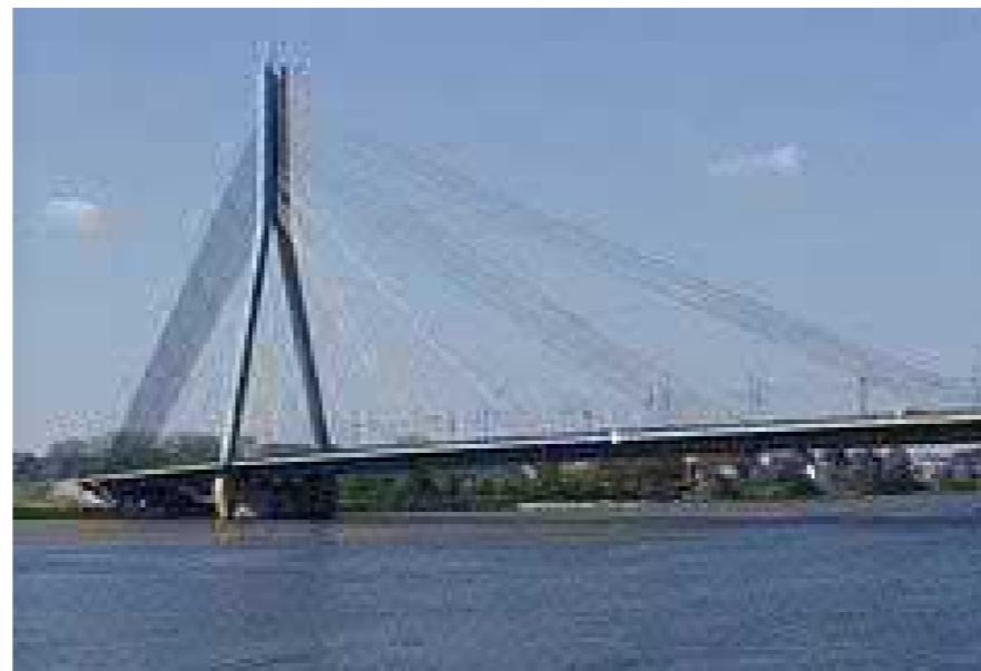
Figur 94. Exempel på snedkabelbro.
