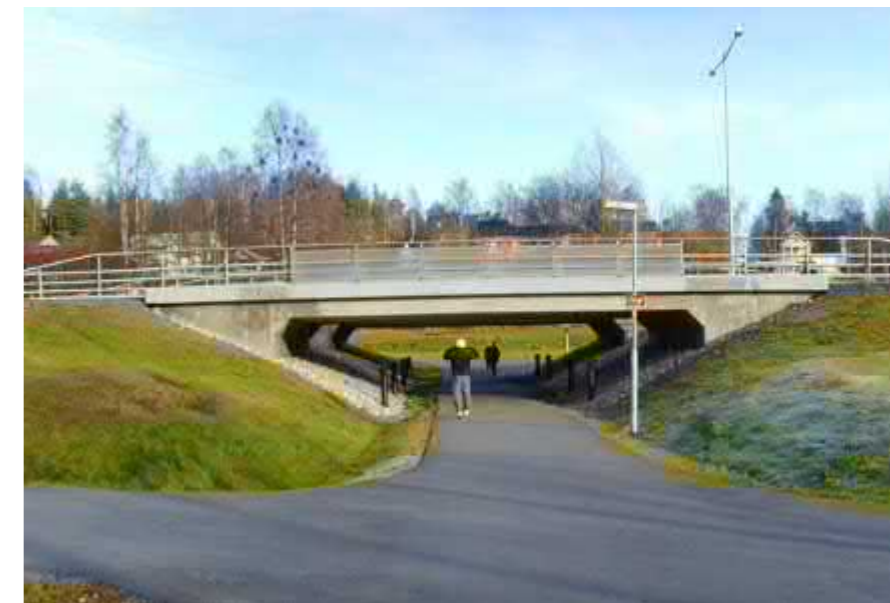
Figur 95. Exempel på planskild gång- och cykelpassage. Foto: Tekniska förvaltningen, Luleå kommun
