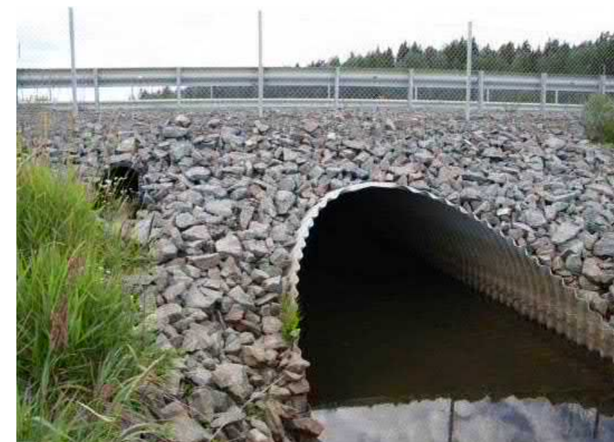
Figur 92. Rörbro vid mindre vattendrag.
