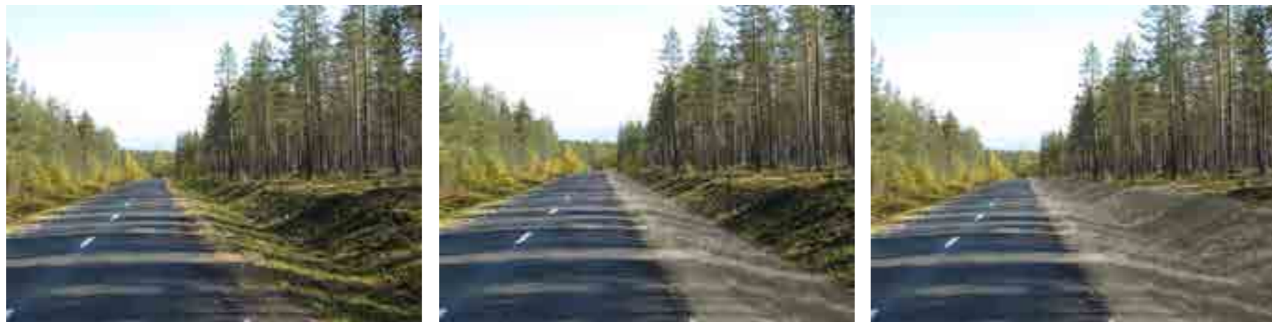
Befintlig vägmiljö i ett skogslandskap, med vegetation fram till körbanan, till vänster.
