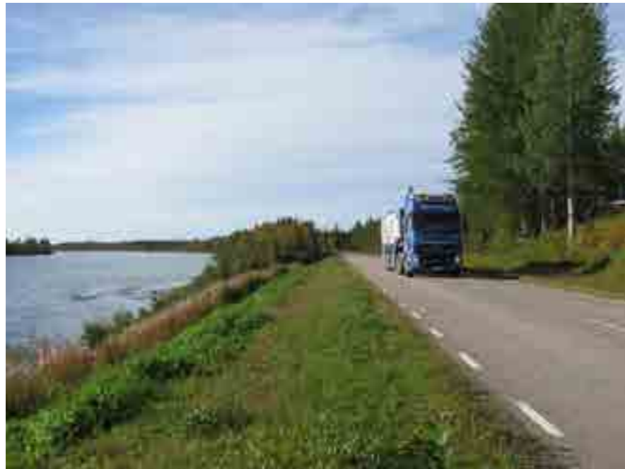
Väg 395 intill Torneälven i Huhtanen.
