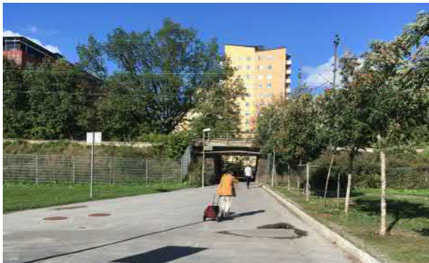
Figur 31. Befintlig gång- och cykeltunnel vid Ankdammsgatan.
