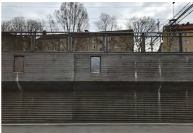
Befintlig stödmur vid Solna tingsrätt
