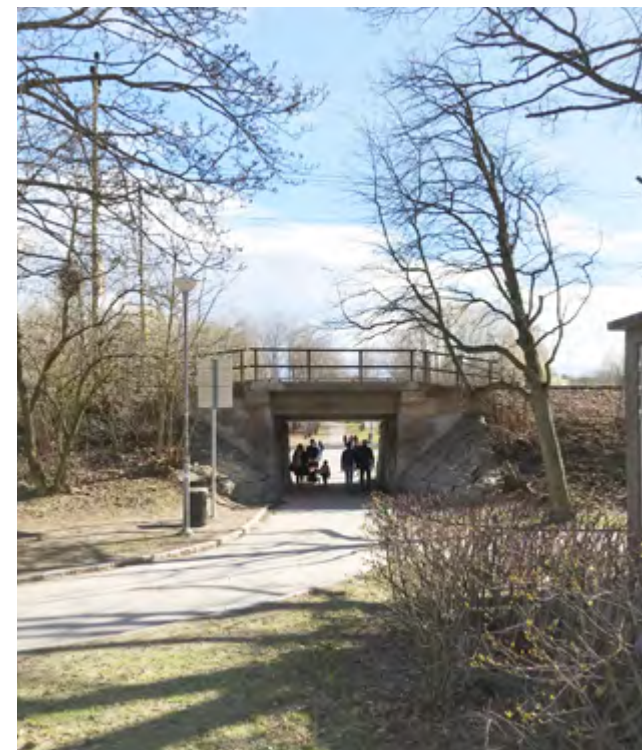
Gång- och cykeltunneln från Ankdammsgatan
