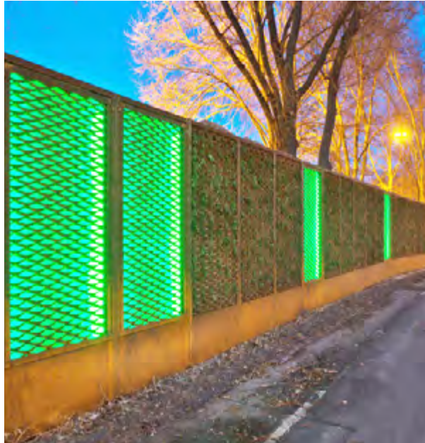
Exempelbild: belysning på bullerskyddsskärm här utmed Lidingövägen
