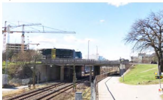
Frösundaledens vägbro och gång- och cykeltunneln under Frösundaleden
