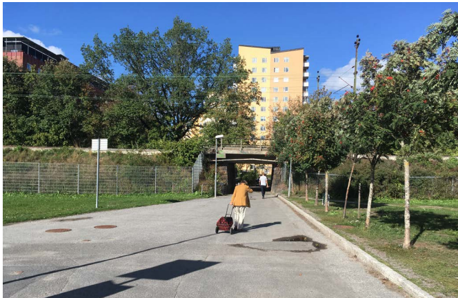
Figur 62. Befintlig gång- och cykeltunnel vid Ankdammsgatan.
