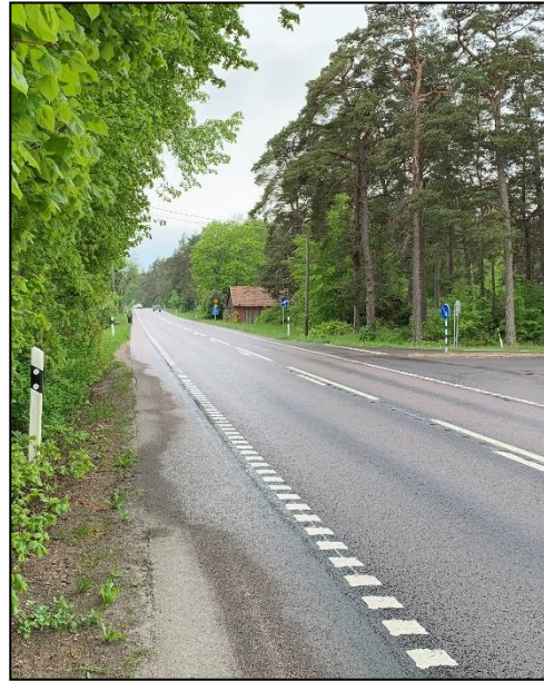
Figur 7 Väggkant markerad för gång- och cykeltrafik vid korsningen mot Stora Rör. Vy söderut.
