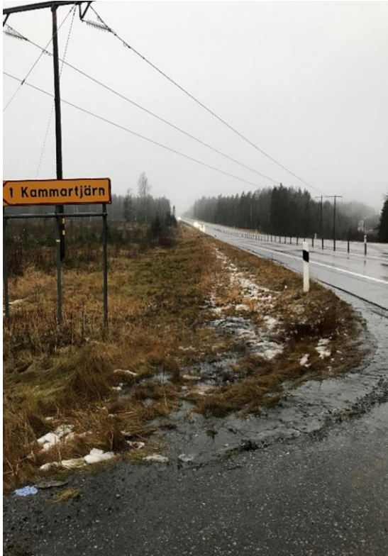
Bild 6 (vänster). Visar sikten norrut i korsningen E4/Kammartjärn där siktsträckan inte bedöms uppnå kraven enligt VGU. Bild 7 (höger). Visar sikten söderut i korsningen E4/Kammartjärn där siktsträckan bedöms vara god.
