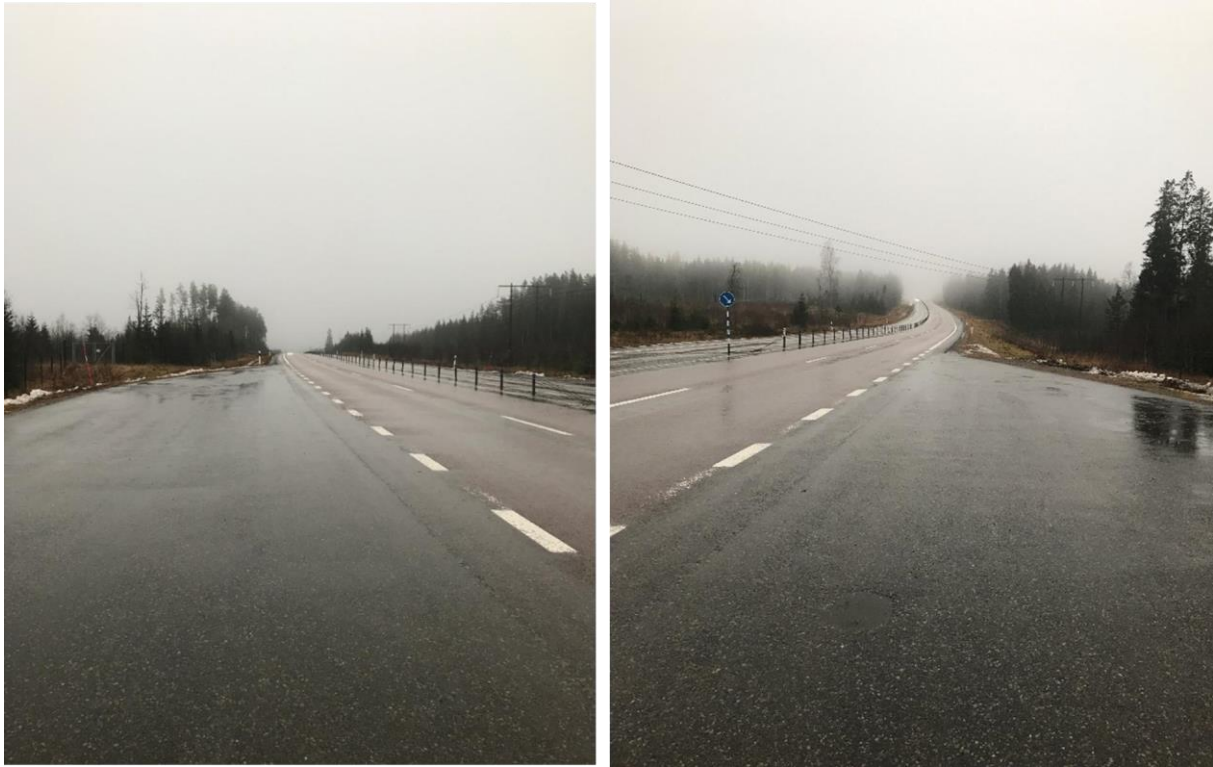
Bild 4 (vänster). Visar sikten norrut i svängfickan där siktsträckan inte bedöms uppnå kraven enligt VGU.
