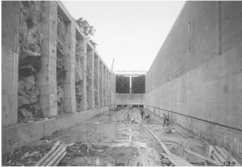
Figur 93. Slussens västra mur muras. Sjöfartsverket.
