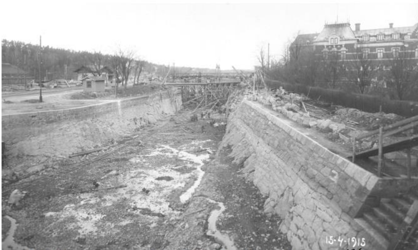
Figur 43. Bergkanalen mot norr Vaktbostaden Klaffbron. Murad kajkant med trappa. 1915 Sjöfartsverket.
