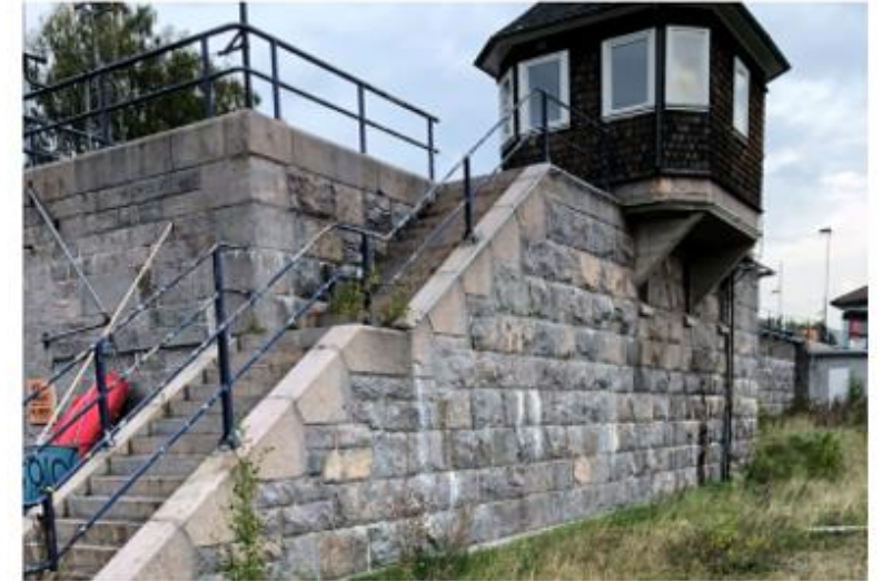
Figur 64. Murverk och trappa med bevarade smäckra järnräcken samt manöverhytt tillhörande 1916 års slussanläggning.
