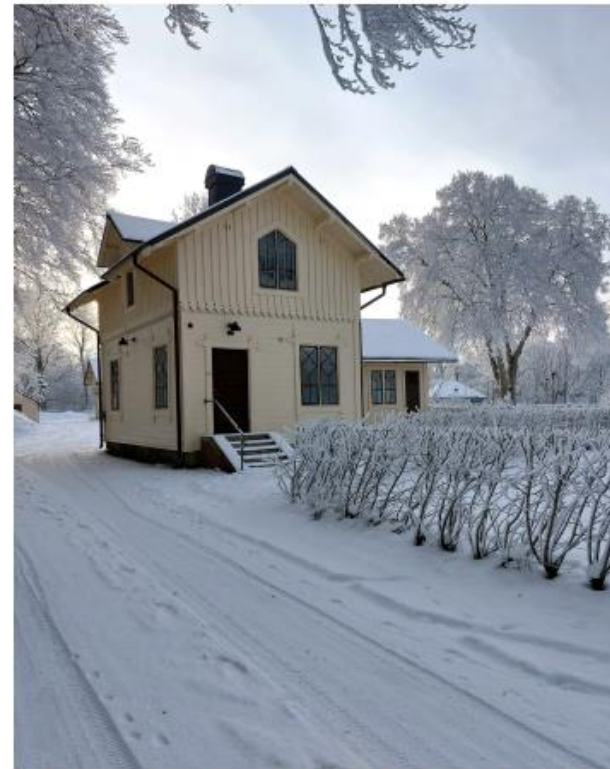
Figur 115. Pannrum/kompressorbod fotograferad från norr. Panelen, fönster- och dörrfodren samt de krysspräjsade fönstren är karakteristiska för 1800-talsbebyggelse kopplad till Trollhätte kanal.
