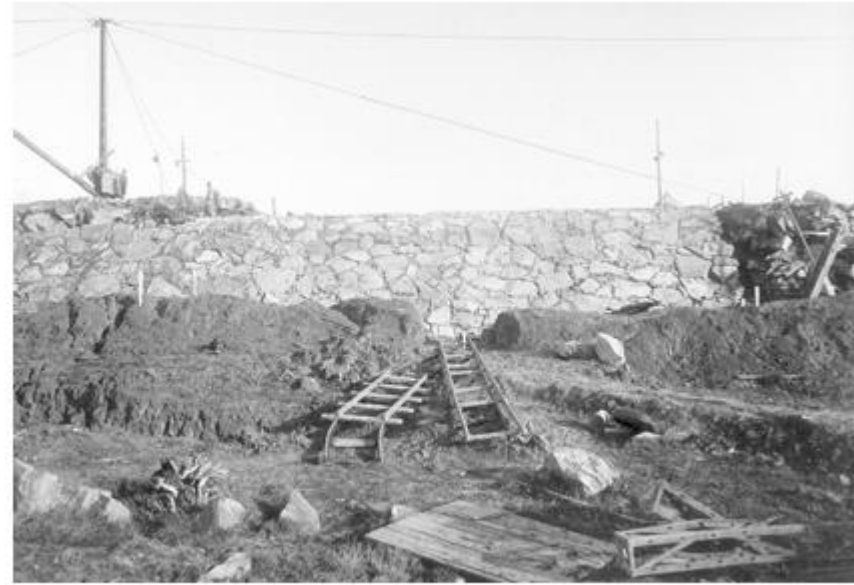
Figur 94. Glacisläggning söder om slussen, ca. 1914. Sjöfartsverket.
