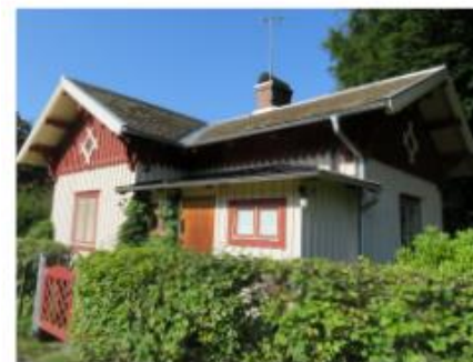
Vaktbostaden Klaffbron (1875), en av vaktbostäderna utmed Bergkanalen. Idag finns två på västra sidan av kanalen och en på östra sidan vid Åkers sjö.
