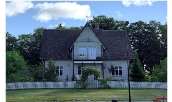
Figur 101. Kanalkontoret sett från slussen.
