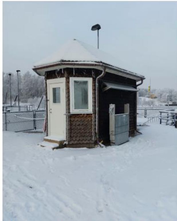
Figur 133. Manöverhytten fotograferad från sydost. Utbytta fönster och dörr är inte anpassade till byggnadens karaktär.
