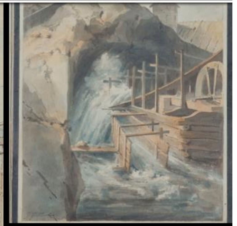
Figur 26. J. F Martins akvarell av Tessins sluss (ca. 1790) är den enda mer detaljerade avbildning av slussen som påträffats under arbetet med kulturarvsanalysen. Här syns hur slussen var utformad liknande Polhems slussar i Trollhättan: en schaktsluss med stollgång insprängd i berget.
