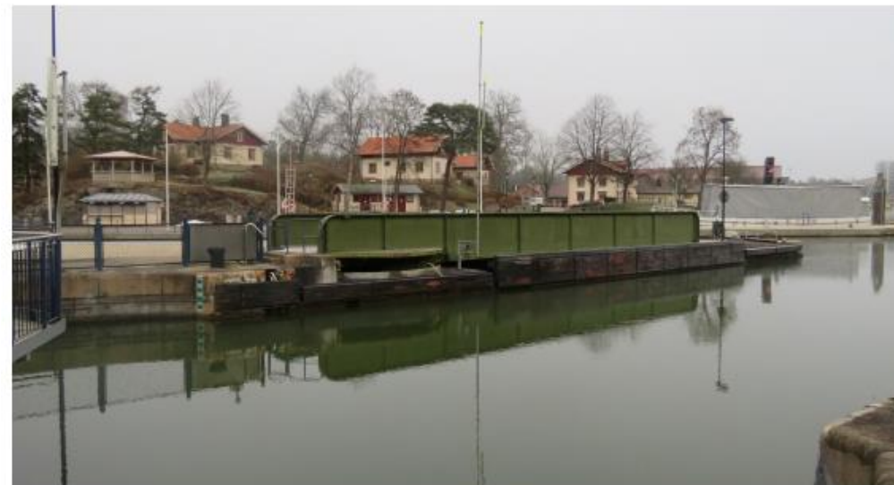
Området vid Åkersberg från andra sidan vattnet. Vid Åkersberg och Förrådsområdet finns en samlad bebyggelse med byggnader med uttryck som är karaktäristiskt för slussmiljön.
