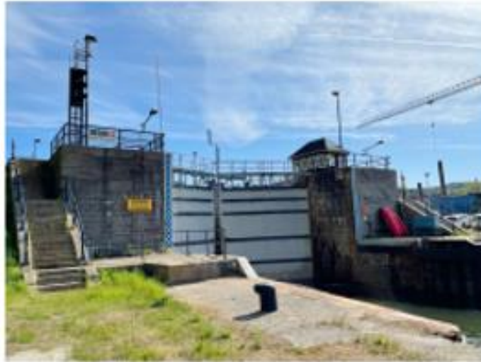
Figur 65. Södra slussporten med murverk och manöverhytt. Porten är inte ursprunglig.
