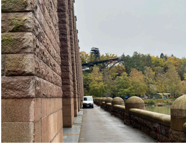
Figur 47 Olidans kraftstation. På nära håll framträder detaljrika och varierade stenarbeten som förstärker byggnadens karaktär både nära och från avstånd.
