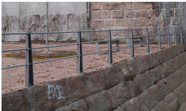
Figur 50 Bildexempel från ett projekt där nya prefabricerade räcken kombineras med äldre murar.
