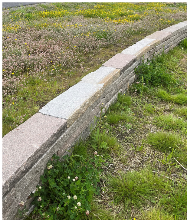
Figur 53 Kantstöd av granit återbrukat som stödmur.
