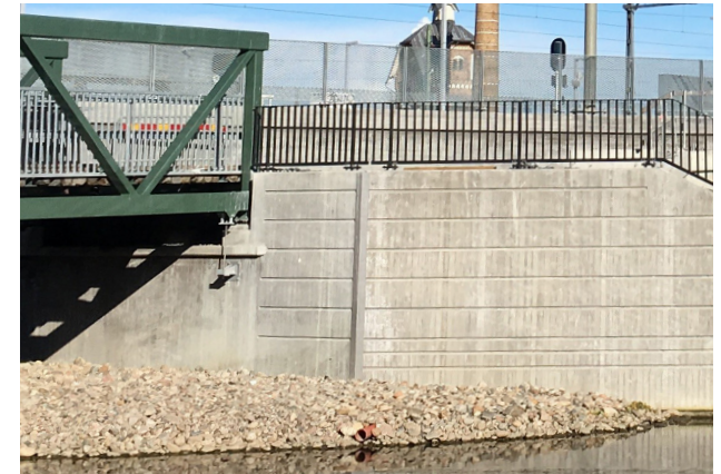
Figur 68 Betongmur gjuten med trälister i formen.
