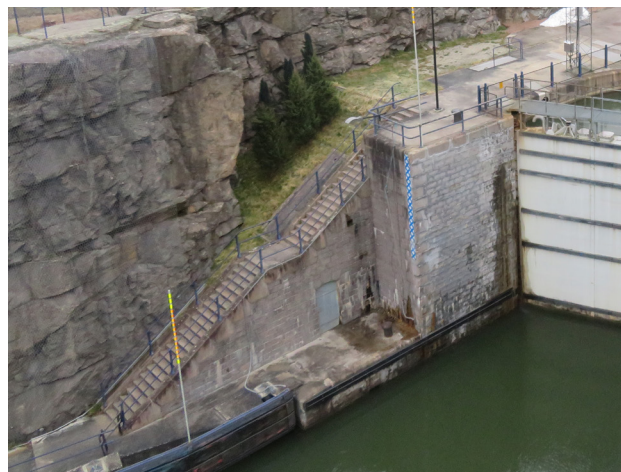
Figur 30 Höga frontmurar och trappor i granit finns på var sida om slussportarna. Pollare och räcken i järn.
