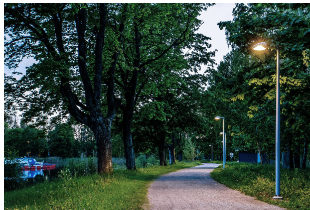
Figur 80 Belysning av gång- och cykelbana. Bild Fagerhult
