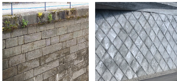
Figur 65 Bildexempel på befintlig äldre mur i Trollhättan och modern betonggjutning.
