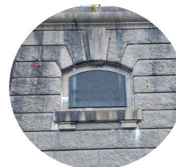
Slussarnas granitklädda murar återkommer i alla tre slussorter.
