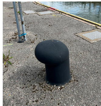
Figur 77 Befintlīga förtöjningspollare
