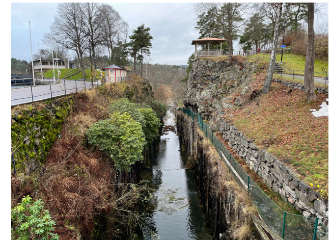
Figur 27 Sluss från 1800 i Trollhättan.
