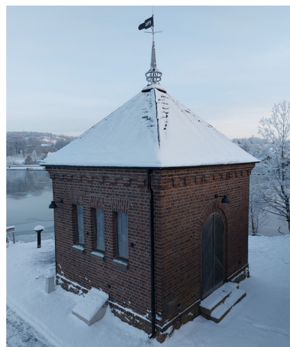
Figur 35 Ställverk i Lilla Edet, uppfört samtidigt som befintlig sluss.
