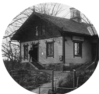
Slussvaktarbostaden i Vänersborg. 1800-talets andra hälft
