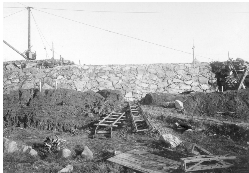
Figur 94. Glacisläggning söder om slussen, ca. 1914. Sjöfartsverket.
