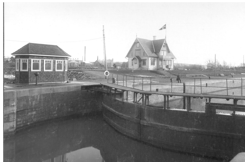
Figur 137. Manöverhytten i slussmiljön 1916. De ursprungliga karaktäristiska fönstren byttes ut senare på 1900-talet. Sjöfartsverket.
