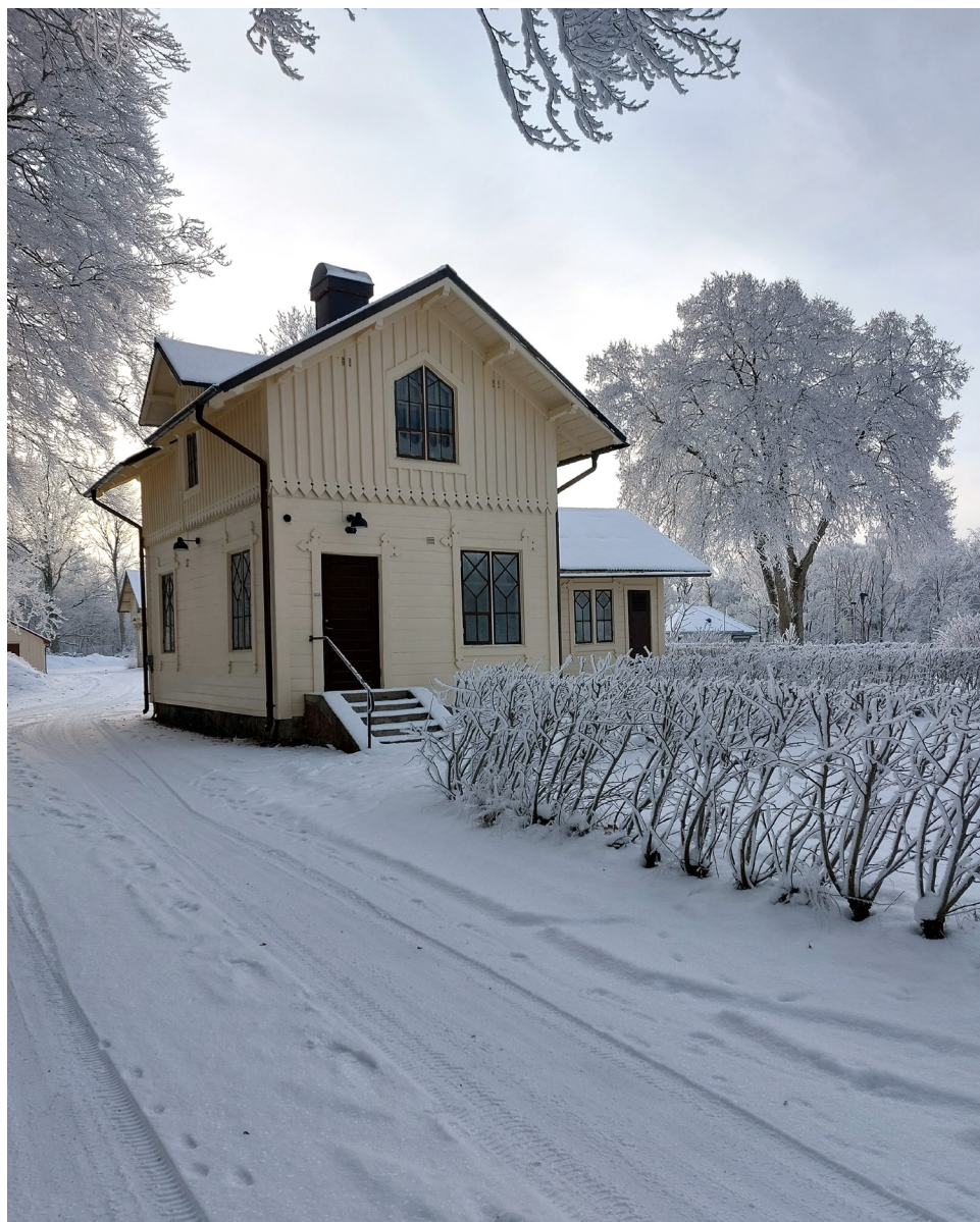
Figur 115. Pannrum/kompressorbod fotograferad från norr. Panelen, fönster- och dörrfodren samt de kryssspröjsade fönstren är karaktäristiska för 1800-talsbebyggelse kopplad till Trollhätte kanal.
