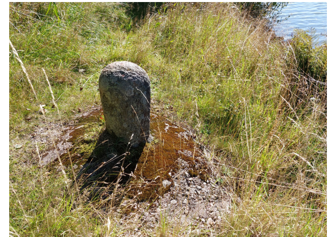
Figur 82. En av de granitpollare med ursprung i 1840-talets slussmiljö som i dag kantar 1916 års kanalled.
