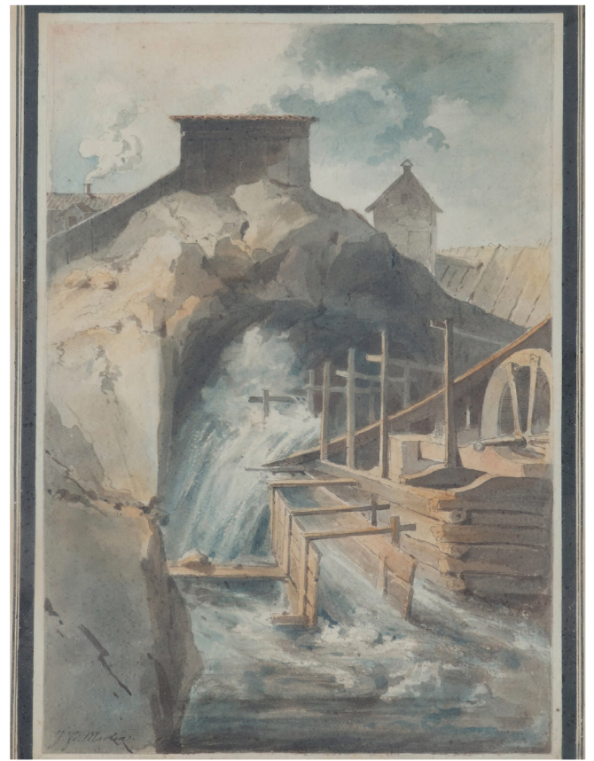
Figur 26. J. F Martins akvarell av Tessins sluss (ca. 1790) är den enda mer detaljerade avbildning av slussen som påträffats under arbetet med kulturarvsanalysen. Här syns hur slussen var utformad liknande Polhems slussar i Trollhättan: en schaktsluss med stollgång insprängd i berget.
