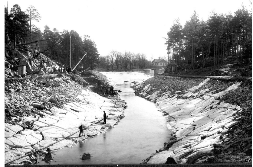
Figur 43. Arbete med nedre delen av Karls grav, ca 1914. Kullens sluss och slussvaktarbostad skymtar i bakgrunden. Sjöfartsverket.
