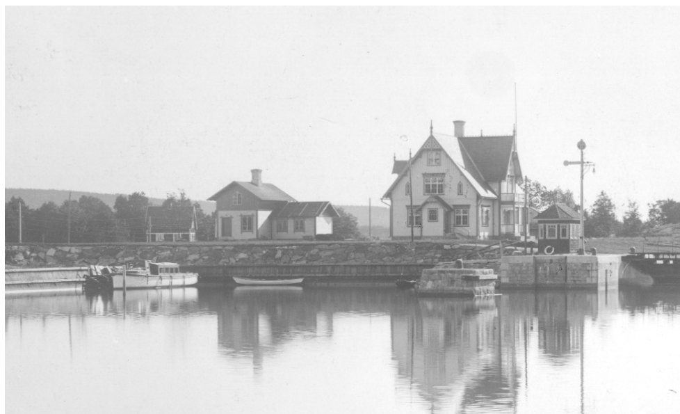
Figur 117. Byggnaden flyttad till sin nuvarande plats vid 1916 års sluss. Sjöfartsverket.
