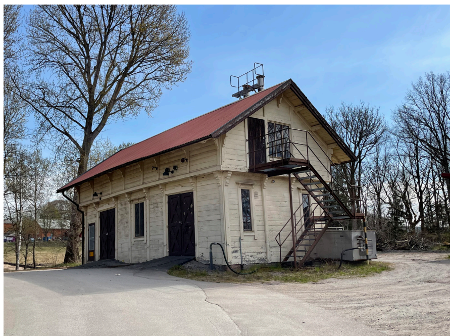
Figur 120. Ekonomibygnaden fotograferad från nordväst.
