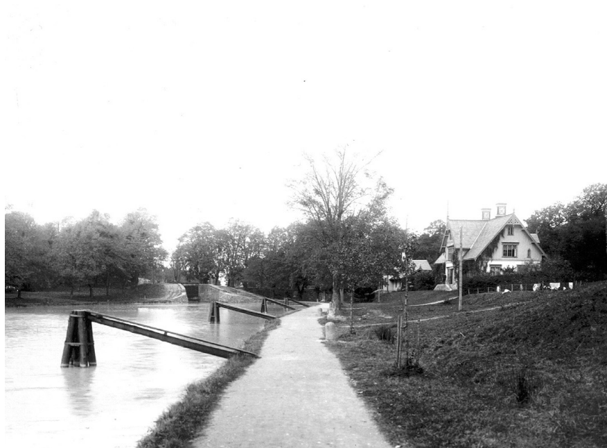
Figur 28. Foto från 1910 som visar Kullens sluss sedd från syd. Kanalkontoret, som sedan flyttades söderut till dagens slussmiljö, till höger. Bilden är tagen precis innan Kullens sluss revs och arbetena med dagens sluss påbörjades. Sjöfartsverket.
