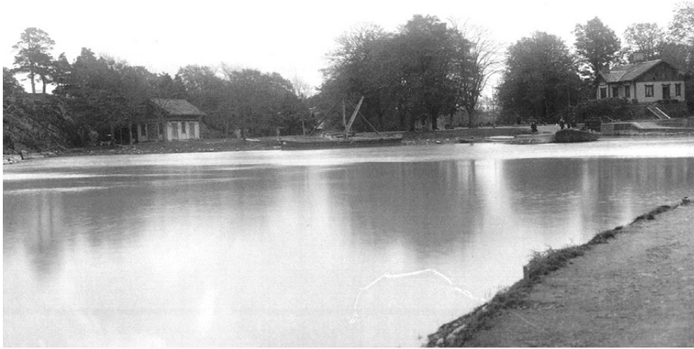
Figur 126. Ekonomibyggnaden på ursprungligt läge på västra sidan om Kullens sluss, ca. 1914. Sjöfartsverket.
