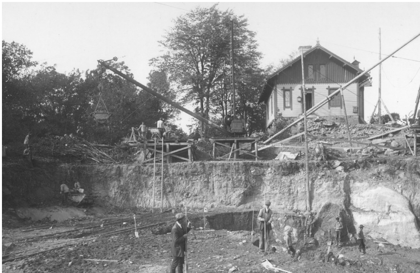
Figur 143. Byggnaden på ursprunglig plats med jordschakt i förgrunden. Sjöfartsverket.
