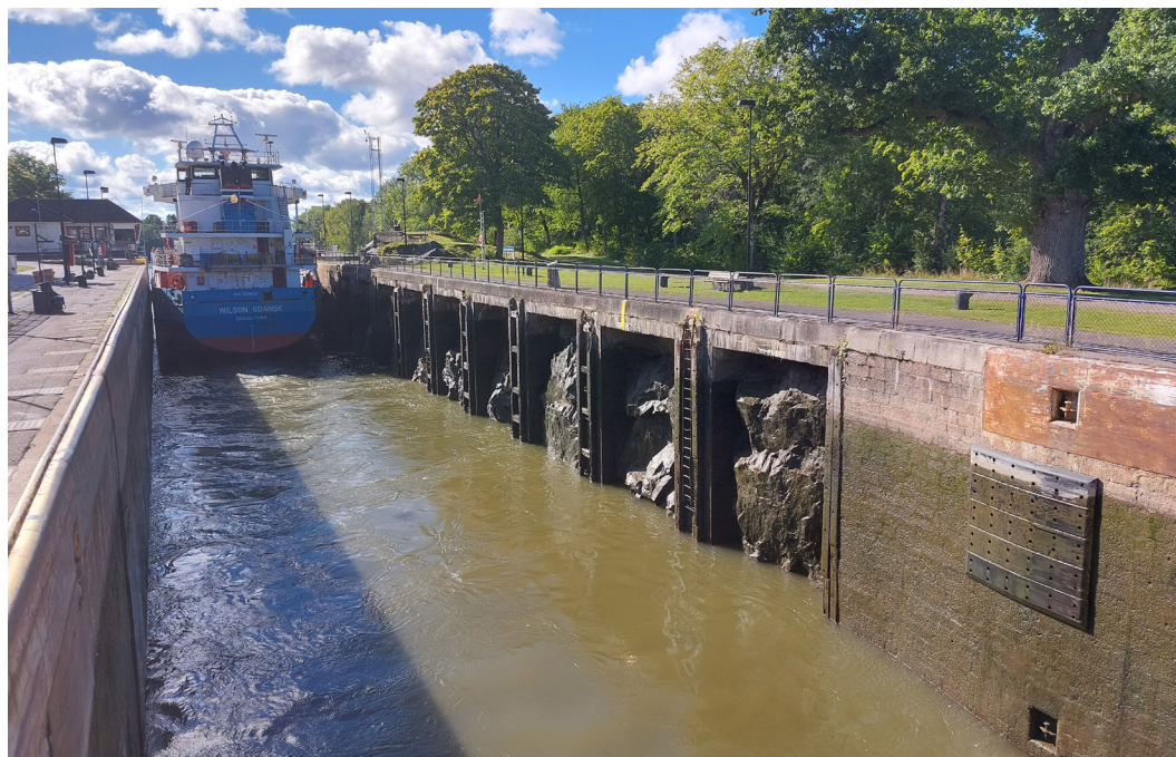
Figur 98. På slussens västra sida syns att den är placerad i berg.
