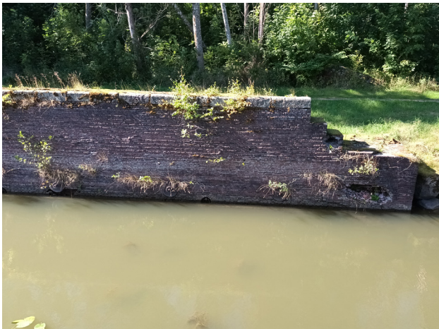
Figur 80. Bevarad mur från Gustafs tegelssluss (1770-tal).
