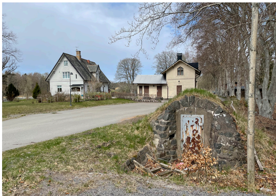
Figur 102. Bebyggelse i 1916 års slussmiljö: kanalkontoret, ekonomibygnad och jordkällare.
