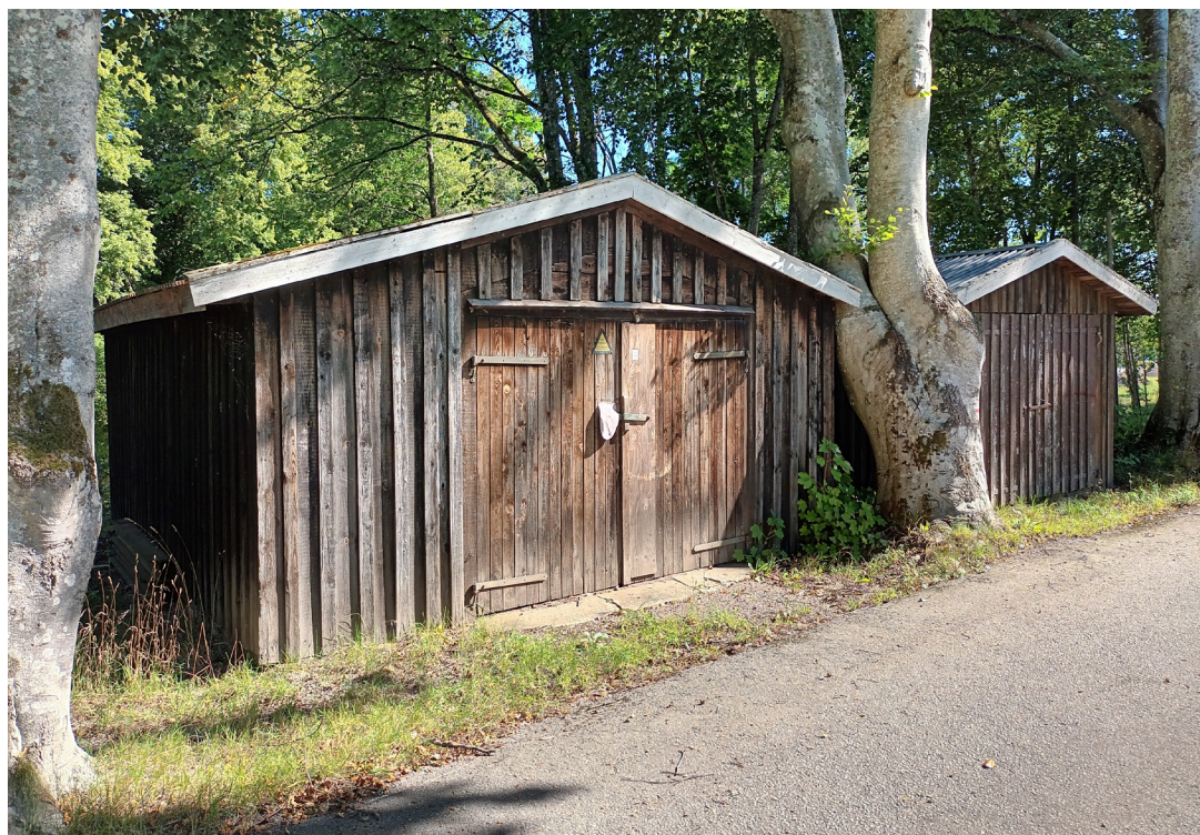
Figur 151. Garagen fotograferade från Slussvägen.
