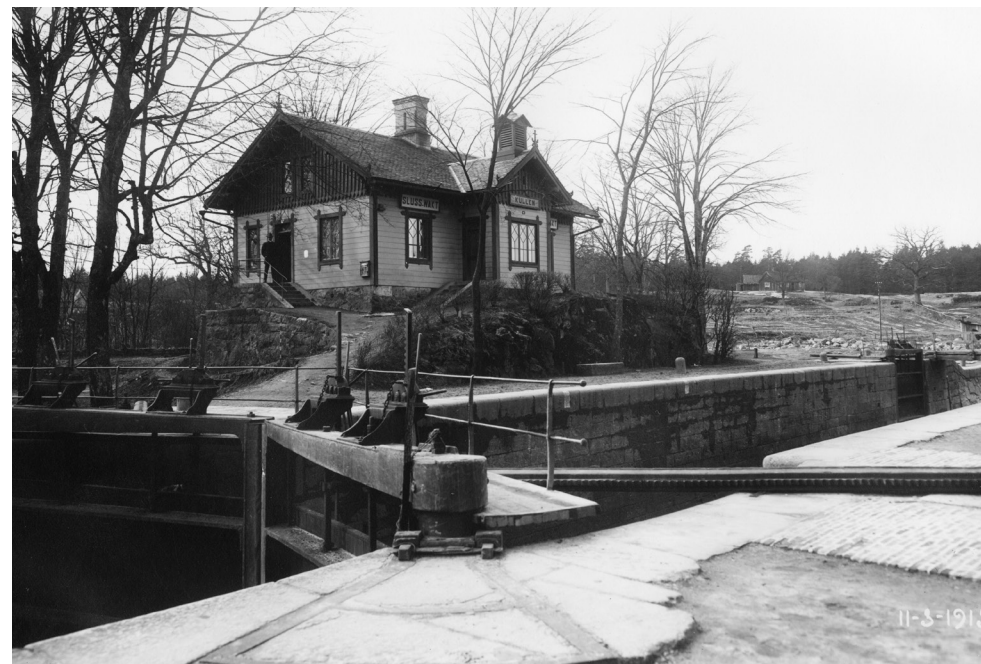
Figur 34. Kullens sluss och slussvaktarbostad sedd från sydöst 1913, strax innan slussrivningen. Murpartiet närmast i bild finns kvar i dag. Byggnaden flyttades till miljön kring 1916 års sluss. Sjöfartsverket.
