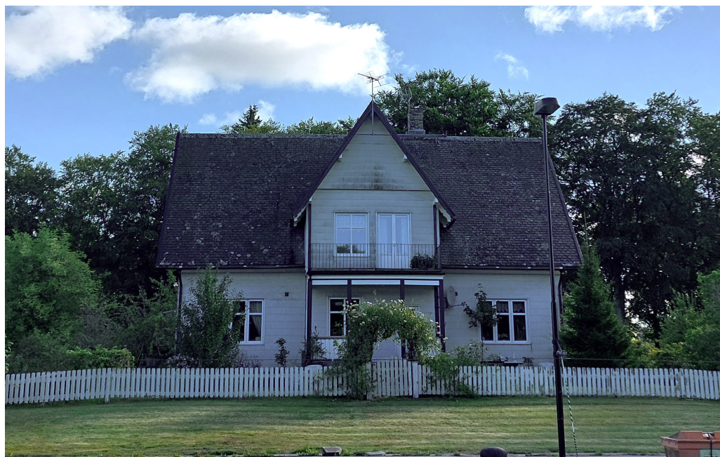
Figur 101. Kanalkontoret sett från slussen.
