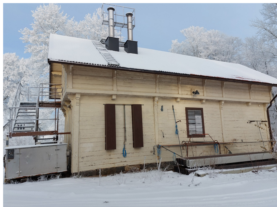
Figur 121. Ekonomibygnadens södra fasad.
