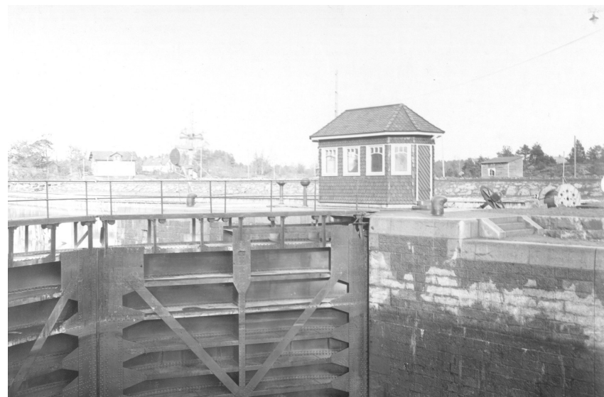
Figur 138. Manöverhytten placerades intill slussportarna. Notera ursprunglig dörr. Sjöfartsverket.
