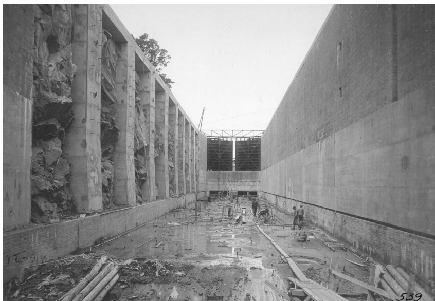
Figur 93. Slussens västra mur muras. Sjöfartsverket.
