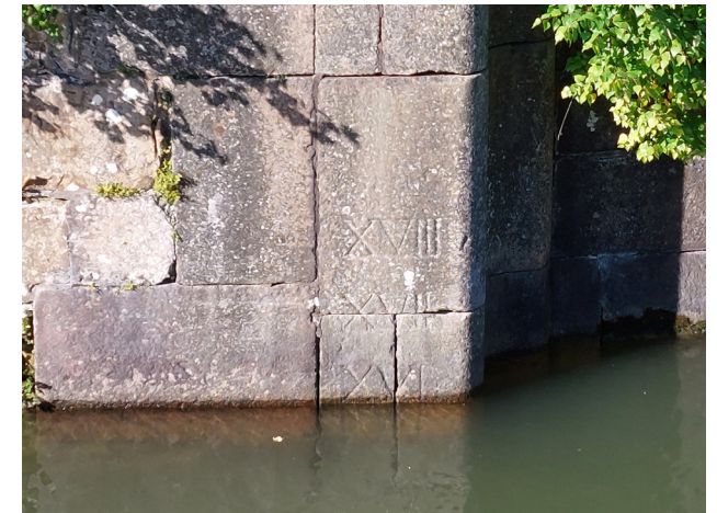
Figur 87. Detalj över mätning av vattennivån i Bommeslussens murverk (1840-tal).
