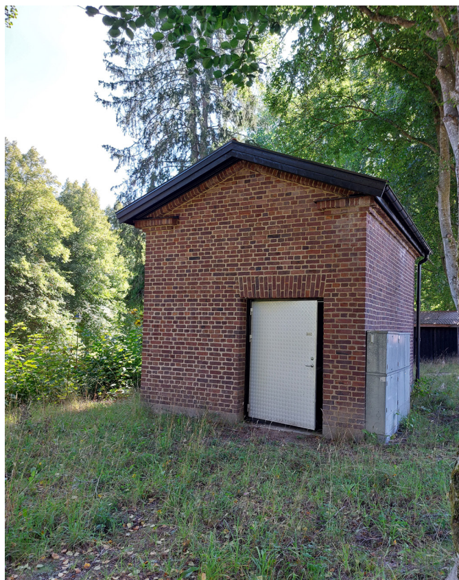
Figur 131. Ställverkets norra gavel med modern dörr.
