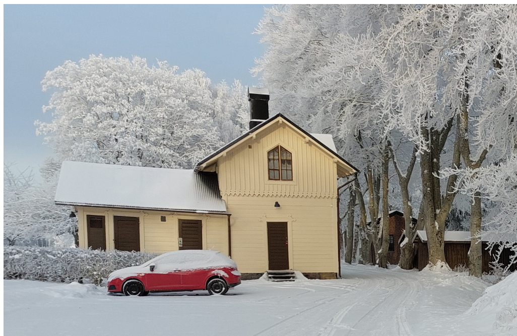
Figur 113. Pannrum/kompressorbod fotograferad från syd. Byggnaden utgör ett mycket välbevarat exempel på kanalbebyggelsen från 1800-talets senare hälft.
