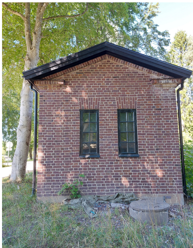
Figur 132. Ställverkets södra gavel med karaktäristiska småspröjsade fönster. Dekorativ takfot murad i rullskift.
