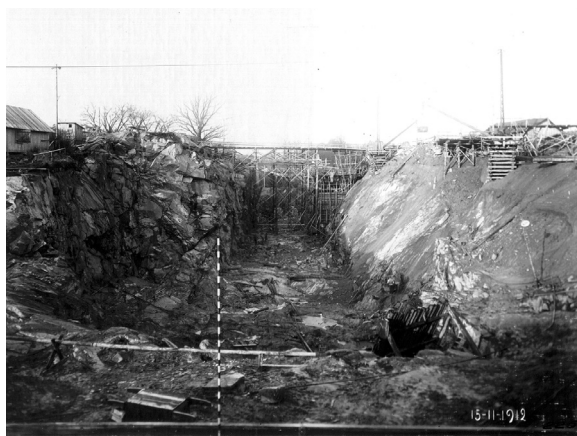
Figur 89. Sprängningen av slussbassängen påbörjad, 1912. Sjöfartsverket
