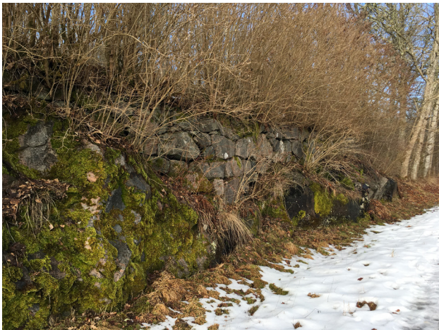
Figur 85. Grunden till den nu rivna slussvaktarbostaden vid Bommeslussen är fortfarande synlig.
