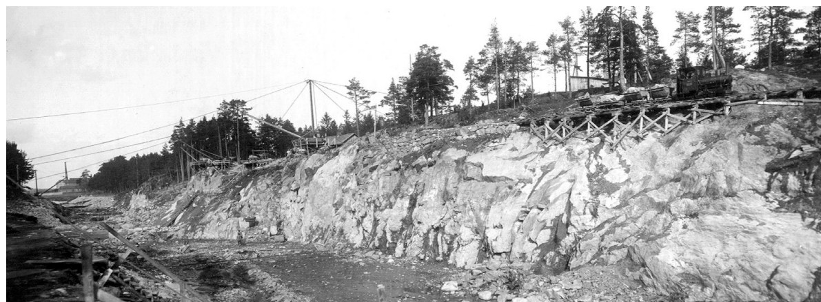
Figur 40. Karls grav utvidgas norr om slussen, 1913. Fridhems tegelbruk syns i horisonten. Notera dcauvillebanan samt lok uppe på berget. Sjöfartsverket.
