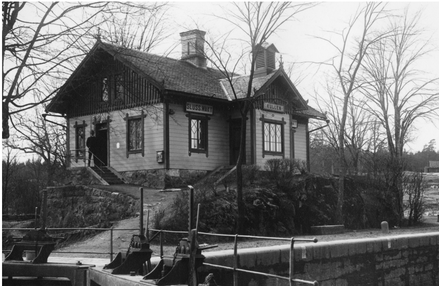
Figur 142. Kullens slussvaktarbostad på ursprunglig plats intill Kullens sluss. 1913. Sjöfartsverket.
