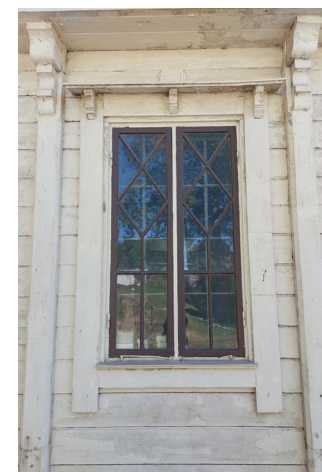
Figur 125. Ursprungligt fönster med för Trollhätte kanal karaktäristisk krysspröjs och dekorativ omfattning.
