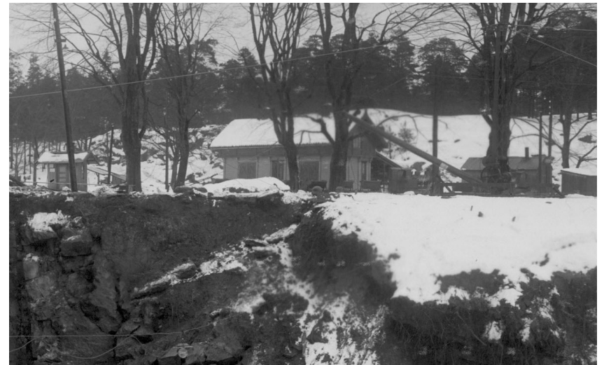
Figur 127. Ekonomibyggnaden på ursprunglig plats år 1915, med pågående slussarbete i förgrunden. Sjöfartsverket.
