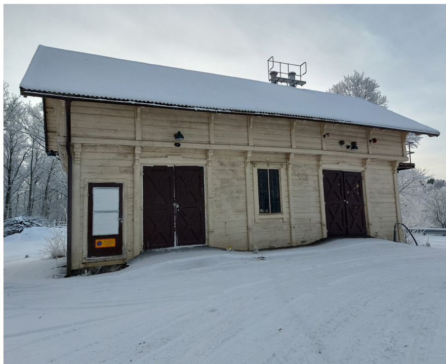
Figur 119. Ekonomibyggnadens norra fasad.
