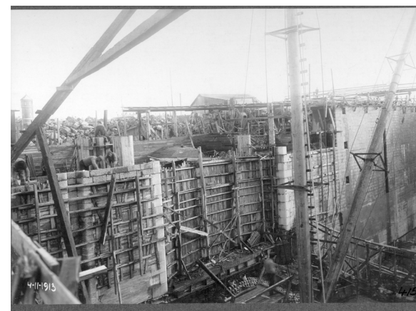
Figur 90. Övre portkammarens östra sida under uppbyggnad, 1913. Sjöfartsverket
