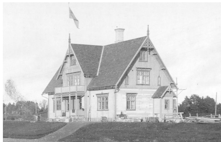
Figur 107. Kanalkontoret 1915. Jämfört med Figur 104 syns att byggnaden fått en ny entréutformning åt väster med balkong och farstuvist. Sjöfartsverket.
