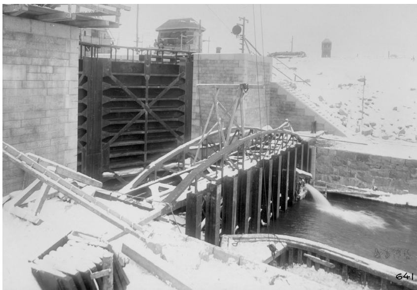
Figur 95. Arbeten vid 1916 års sluss. På fotot syns de ursprungliga slussportarna och avstängningsanordning vid slussens nedre del. Sjöfartsverket.
