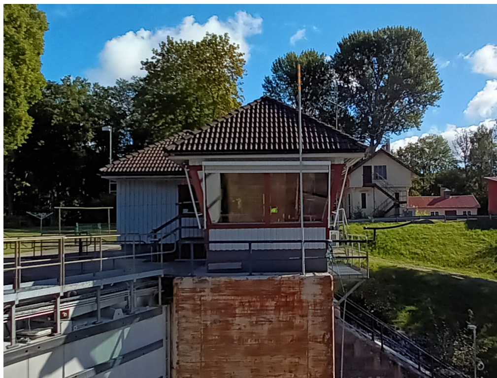
Figur 147. Den moderna manöverhytten, placerad på en avsats vid den södra slussporten.
