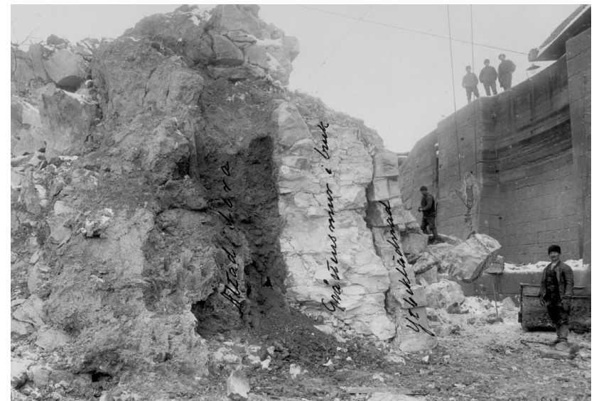
Figur 45. Rivning av Kullens sluss sett från syd, 1915. Här syns det gamla murverket i genomskärning, och dess sammansättning har skrivits in för hand: åldad lera, gråstensmur i bruk samt ytbeklädnad. Sjöfartsverket.
