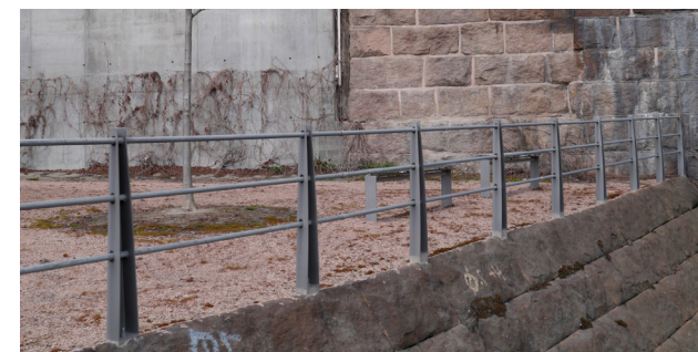
Figur 17 Prefabricerade räcken i ett projekt där nytt och gammalt kombineras.
