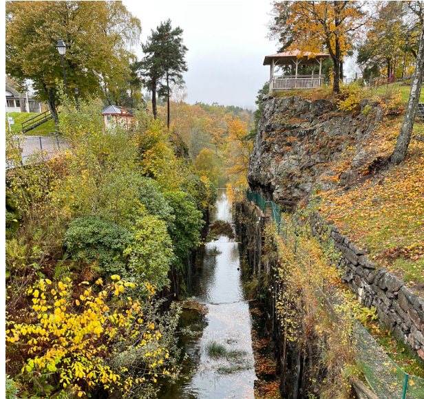
Figur 8 Den övre etappen av 1800 års slussar i Trollhättan.
