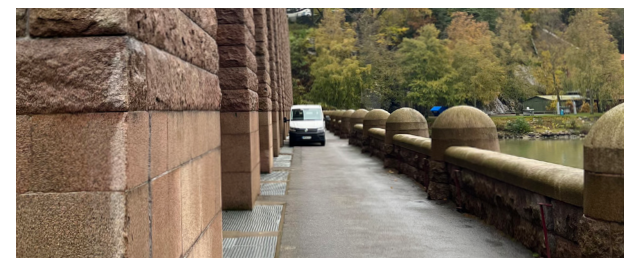
Figur 14 Olidan kraftstation. På nära håll framträder detaljrika och varierade stenarbeten som förstärker byggnadens karaktär både nära och från avstånd.
