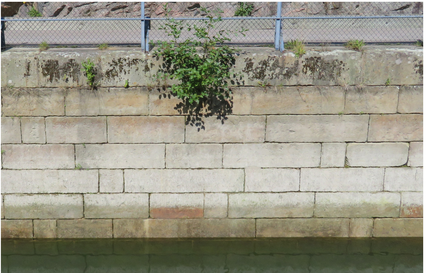
Detalj av de murade slussväggarna i övre etappen.
