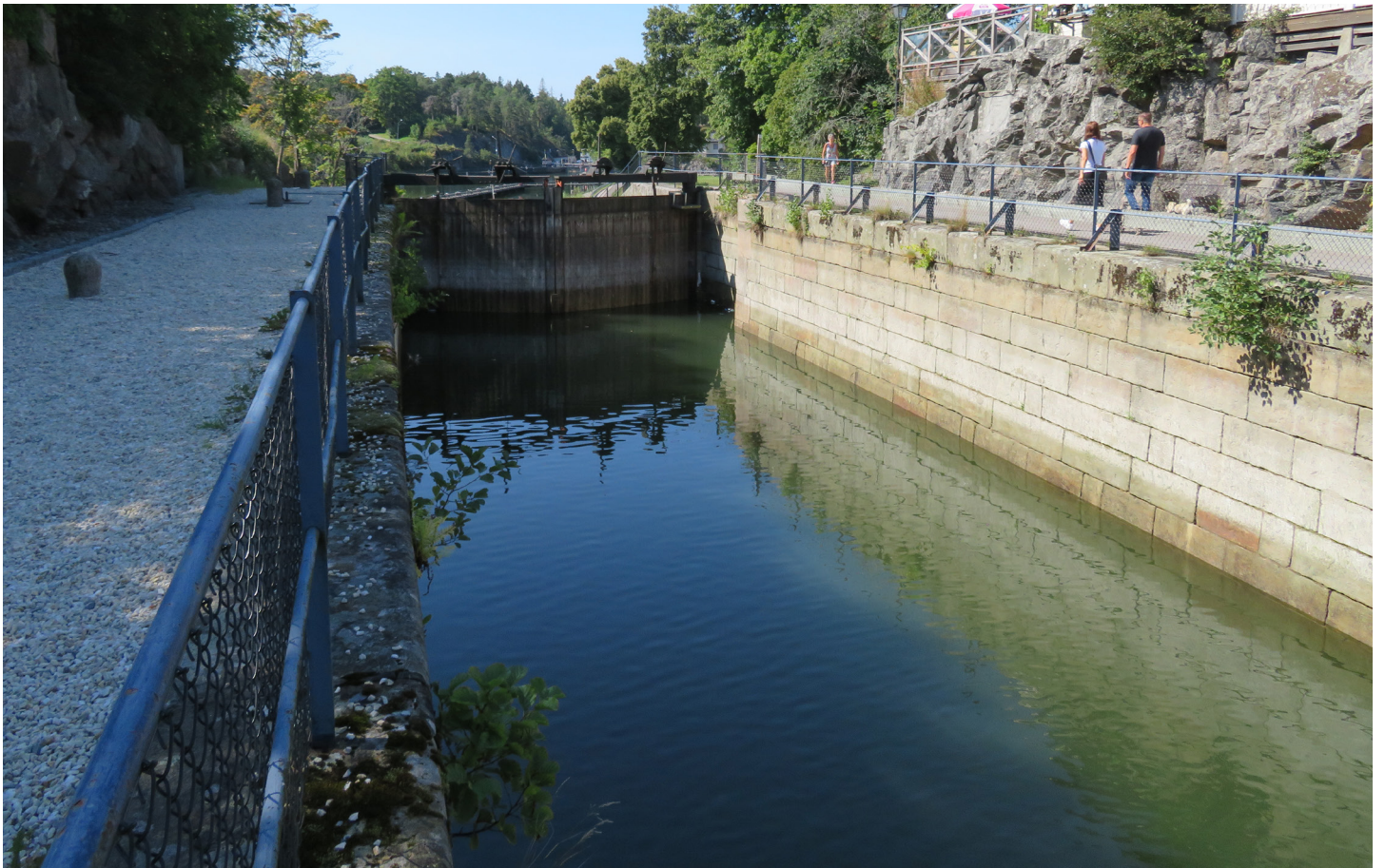
1844 års slussar, övre etappen. Kanalen murad av stenblock.
