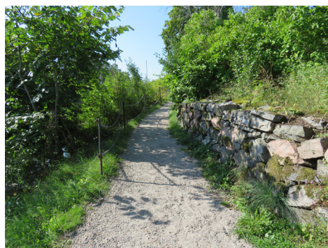
Kallmurad stenmur av stora, grovhuggna block vid promenadvägen utmed Bergkanalen
