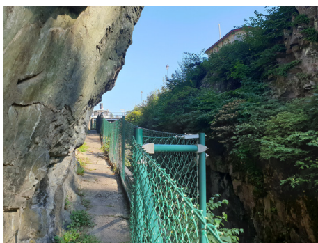
Väg insprängd i berget utmed 1800-års slussar.
