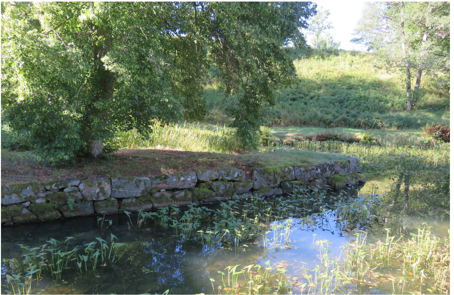
1800 års slussar. Mellan övre och nedre etappen. .
