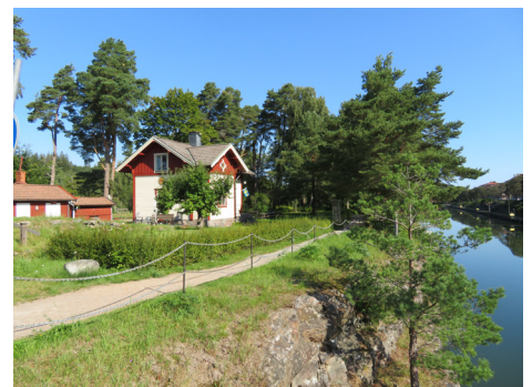
Vaktbostäderna väl synliga från parkstråk utmed kanalen. Byggnaden till vänster är vaktbostaden på Kanalön, till höger syns den sprängda delen av Bergkanalen.
