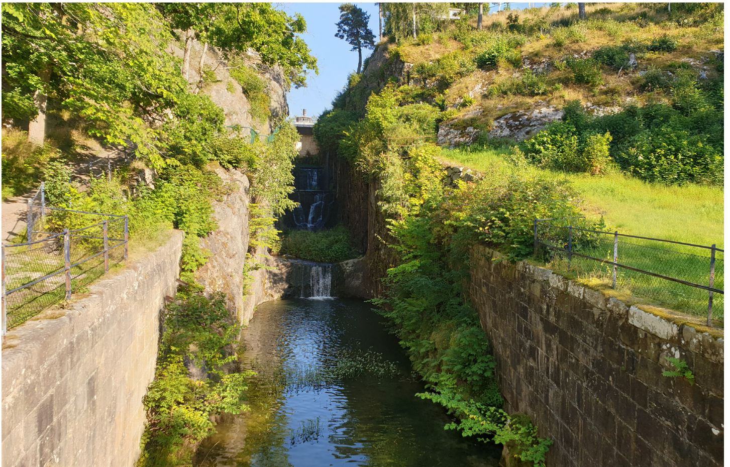
1800 års slussar. Övre etappen sedda nedifrån. Här syns den nedre delen av den övre etappen med väggar murade av kvaderstensblock. Här är också den stora höjdskillnaden tydlig, genom den ångbåt som anas i inloppet vid Åkers sjö.
