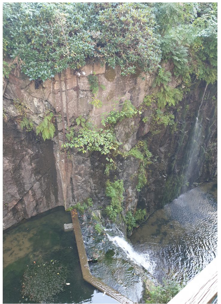
1800 års slussar. Övre etappen. kanalen är sprängd, men vissa delar är murade. Här har en av slussportarna stått. (Betongen tillkommen i modern tid.)
