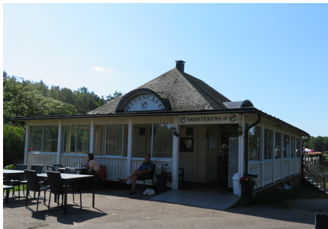
Slusscaféet, uppfört 1908 som vilostuga för slussgossar. Tillbyggt med altaner för caféet.
