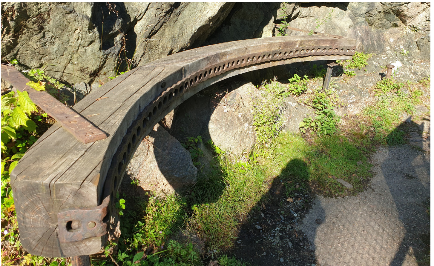
1800 års slussar. Övre etappen. Utmed slussarna har tekniska installationer underhållits, vilket hjälper till att förstå slussarnas funktion. Fotot visar en båge i trä som hörde till portens öppningsanordning, en sk spetteport. Intill finns även skyltar som berättar om tekniken. Porten förlängdes med en stock vars ände följde bågen och stocken baxades runt med ett spett. (Detta är en återskapad replika.)
