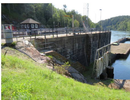
Slussleden mot Göta älv med höga naturstensmurar och de små manöverhytterna i anslutning till slussportarna. Slussanläggningens monumentala uttryck.
