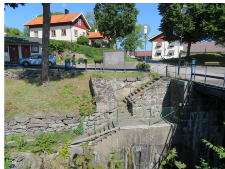
Kallmurad stenmur och trappor vid 1800-års kanal, övre etappen.
