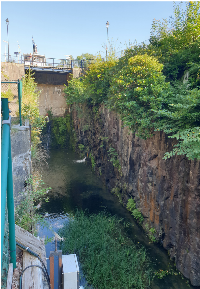
1800 års slussar. Övre etappen. Övre etappen utgörs av sprängd kanal. Kanalen är igenmurad mot Åkers Sjö.
