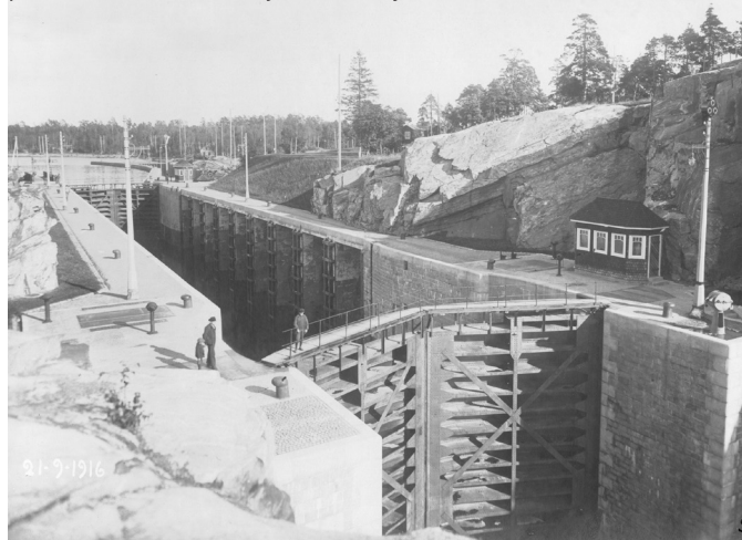
1916 års slussar med stenlagda kajkanter, pollare, slussportar och manöverhytt. Foto: Sjöfartsverket ca 1916.
