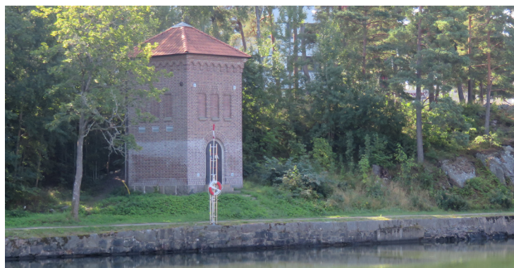
Ställverk vid Åkers sjö, uppfört ca 1914. Möjligen ritad av Svante Dyhlén, som var anställd vid Vattenfall och ritade ett snarlikt ställverk vid slussen i Lilla Edet.
