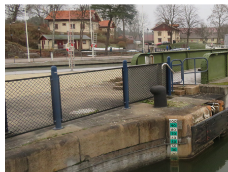
1916 års slussar och kanaler kantas i stora delar av miljön av stenkajer där blocken huggits individuellt i mjukt rudade former. Att anläggningen är utformad både för sin praktiska funktion och för att vara ett arkitektoniskt verk är tydligt, särskilt i mötet med den mäktiga slussstrappan sedd från Göta älv.
