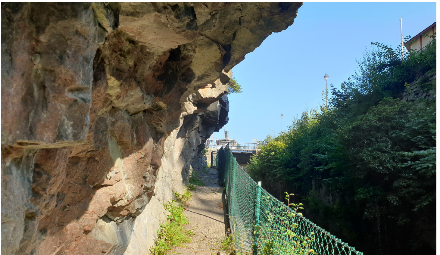
1800 års slussar. Övre etappen. Den utsprängda gångpassagen på norra sidan av slussleden. Detta var slussbiträdets sida medan slussvakten arbetade på andra sidan.
