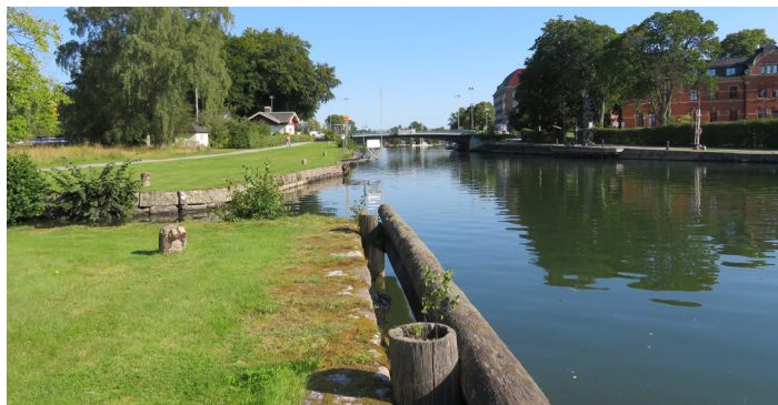
Norra delen av Bergkanalens parkstråk med vaktbostäder och vy mot staden.
