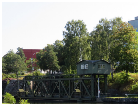
Svängbro tillverkad av Nydqvist & Holm 1915 på kanalens östra sida.
