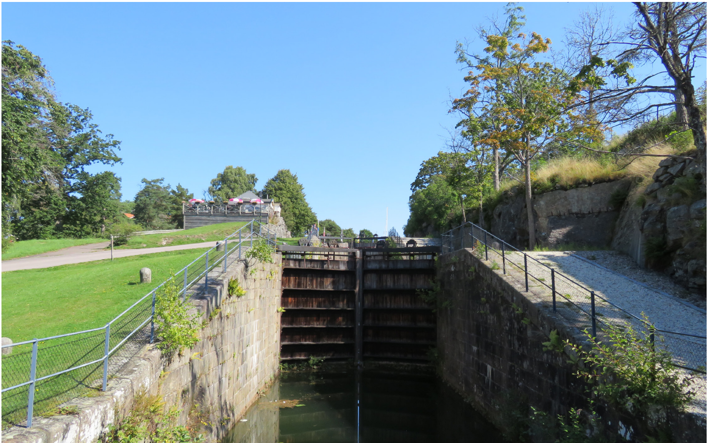
1844 års slussar. Övre etappen, utloppet sett från Höljan.
