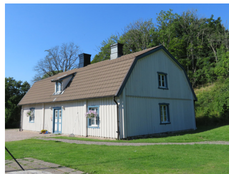
Åkers gårds kvarvarande flygel och ekonomibyggnader. Ekonomibyggnaderna har samma arkitektoniska uttryck som slussmiljöns byggnader, men de är inte förtecknade i skyddsföreskrifterna.
