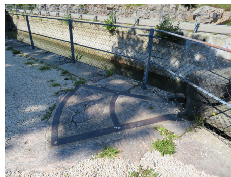
Teknisk utrustning vid slussarna.
