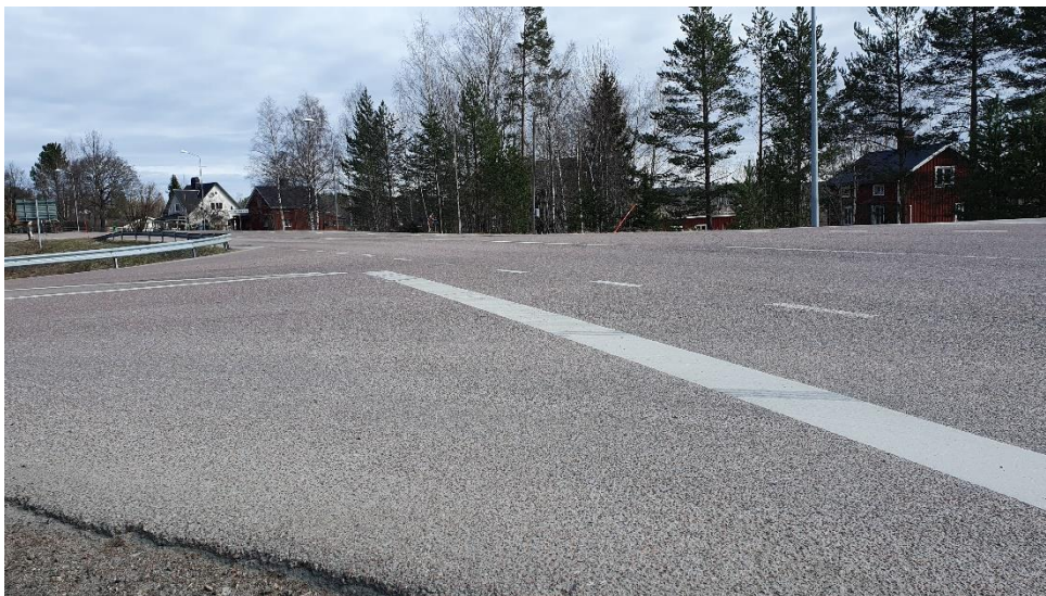
Figur 3 visar befintlig fyrvägskorsning, vy från nordöst.
