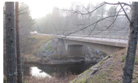
Bild 18. Bro med erosionsskydd av sprängsten
