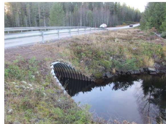
Bild 12. Vägtrumma under väg 1025 där vägområdet är återetablerat med naturlig vegetation
