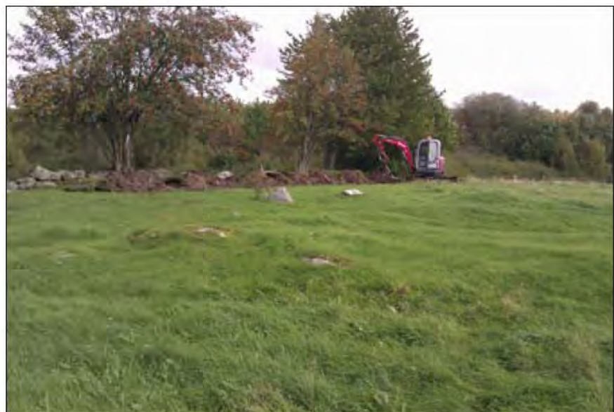
Figur 18. Söschaktning pågår inom område 13. Foto: Jörgen Streiffert.
