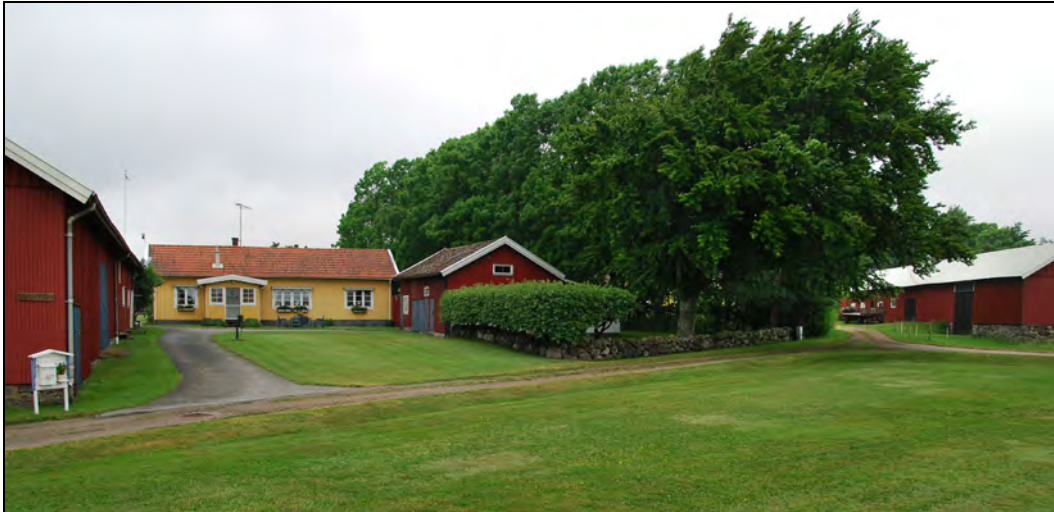
Figur 6. Dagens bebyggelse i södra delen av Mossens gamla bytomt. Bebyggelsen har här fortfarande tydlig bykaraktär, med flera tätt intill varandra liggande gårdar. Vägen i förgrunden har samma sträckning som på 1700-talet. Foto: Pär Connelid (juni 2007).
