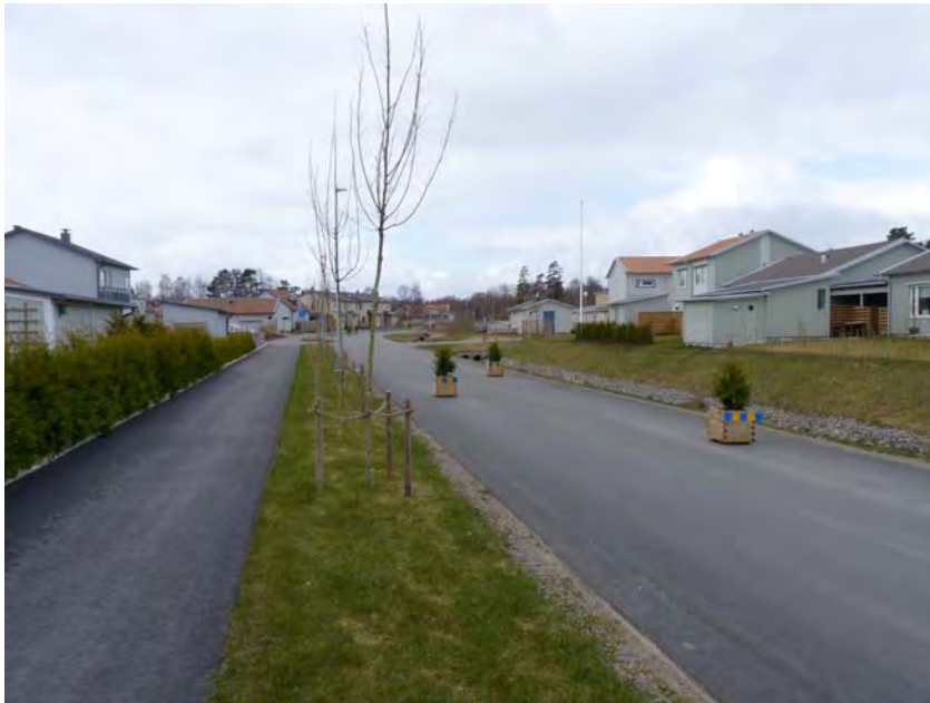
Objekt 8. Det som var våtmark tidigare är nu igenfyllt och bebyggt.
