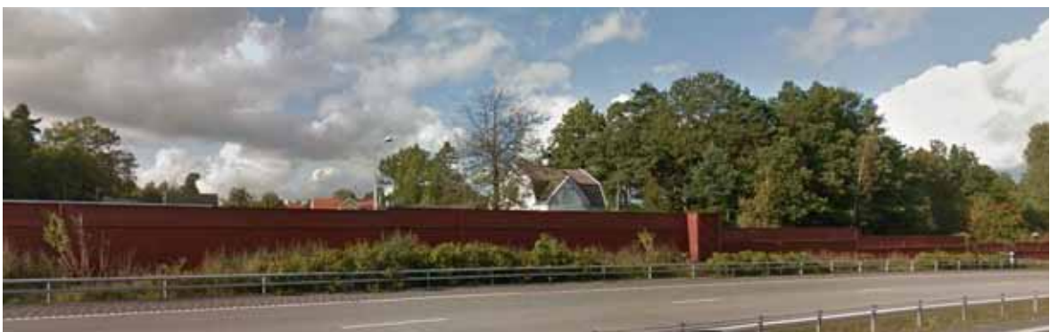
Bildexempel nedan på tänkbara utseenden på bullerskyddsskärmar i trä. Underst: bullerskydd av trä, målat med Falu rödfärg, terrasserat och i kombination med planteringar, bild från Ezo Floda. Bild tv: bullerskydd där endast detaljer är målade i övrigt är det omålat, terrasserat och i kombination med planteringar, bild från Norge. Bild th: bullerskydd i trä, gråmålat, platsanpassat med bakomliggande husfasader, bild från E6/Ezo Gårda, Göteborg
