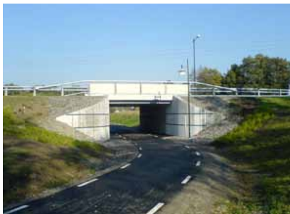
Foto på en port med svängda vingmurar. Bild från väg 767, i Halmstad. (Foto Martin Johansson)
