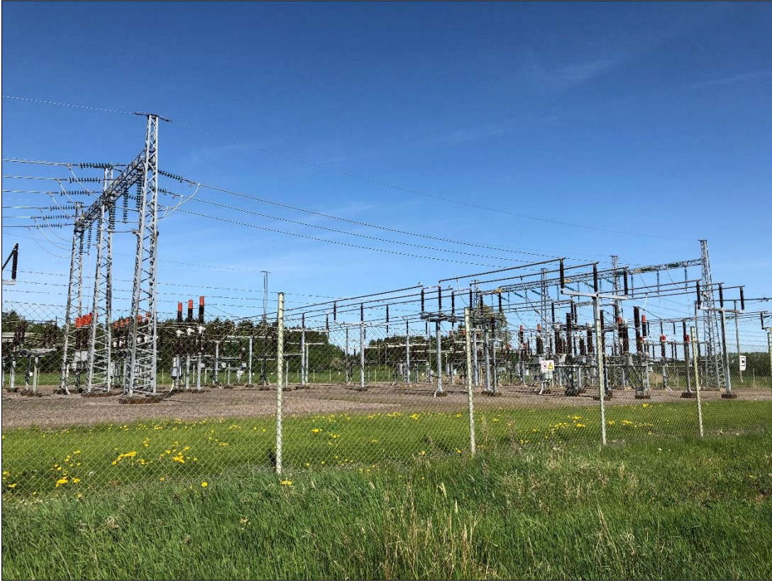
Figur 4. Ställverket från öster.
