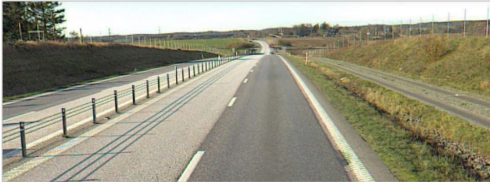
Figur 5. E65 är en mötteseparerad väg med 2+2 körfält. Viltstängsel finns utmed dess båda sidor.
