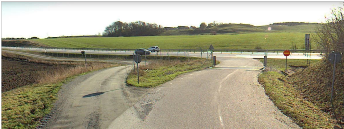
Figur 6. Böringe kyrkovägs östra anslutning till E65. Bilden är tagen mot söder. Grusvägen som ansluter till vänster i bild är en statlig gång- och cykelväg, men det finns ingen skyltning som hindrar även annan trafik från att köra på vägen.
