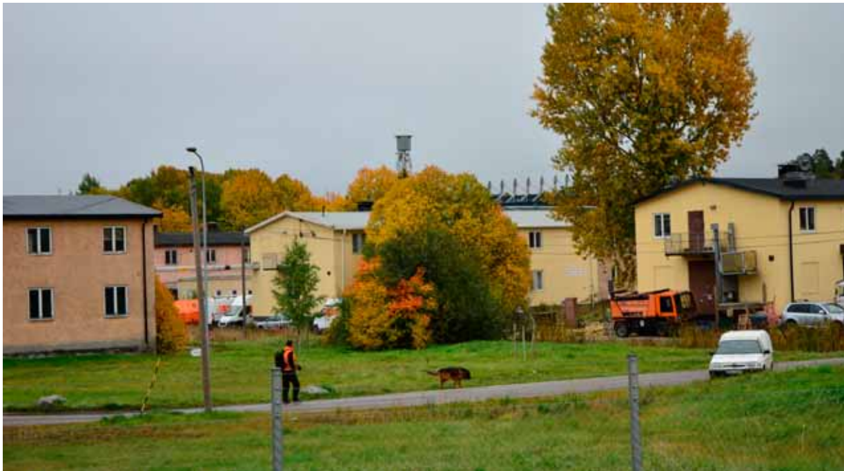
Figur 21. De verksamhetsbyggnader (före detta militärbyggnader) som fram tills nyligen fanns norr om järnvägen vid Solvalla.
