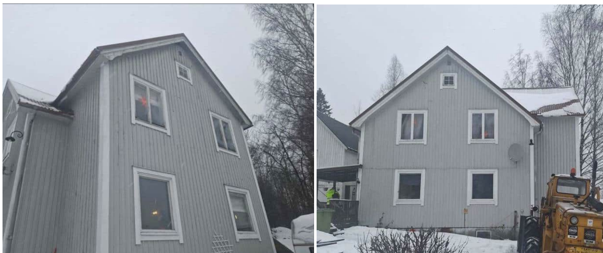
Figur 11. Tv: Fasad mot öster (mot järnvägen). Th: Fasad mot söder
