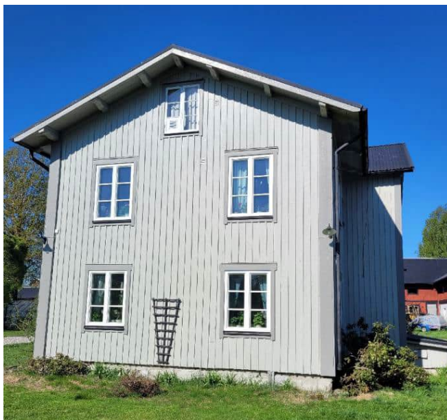
Figur 2. Fasad mot öster (mot järnvägen)
