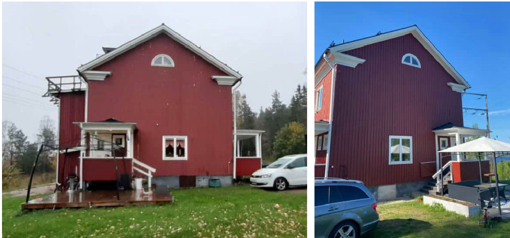
Figur 15. Tv: Fasad mot norr. Th: Fasad mot söder.
