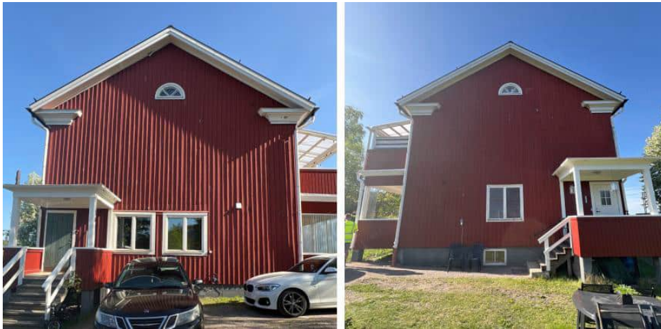
Figur 18. Tv: Fasad mot norr. Th: Fasad mot söder.
