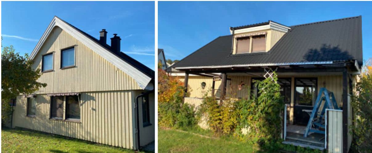
Figur 8. Tv: Fasad mot öster (mot järnvägen). Th: Fasad mot söder
