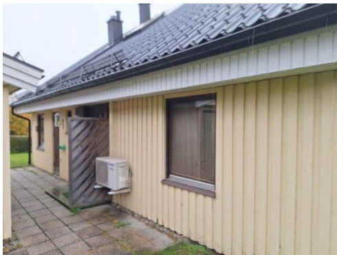
Figur 9. Fasad mot norr.
