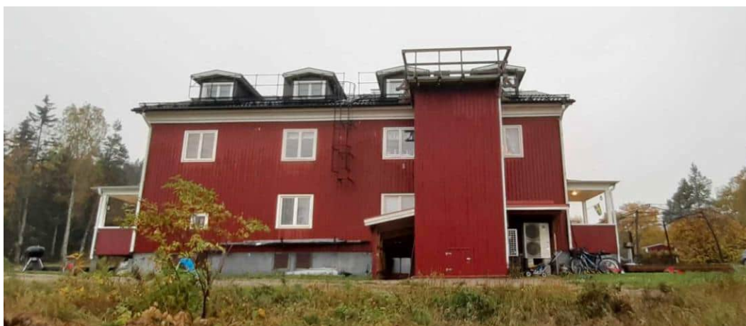
Figur 14. Fasad mot öster
