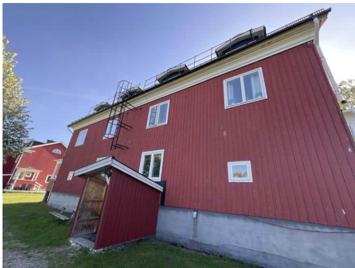
Figur 17. Fasad mot öster.
