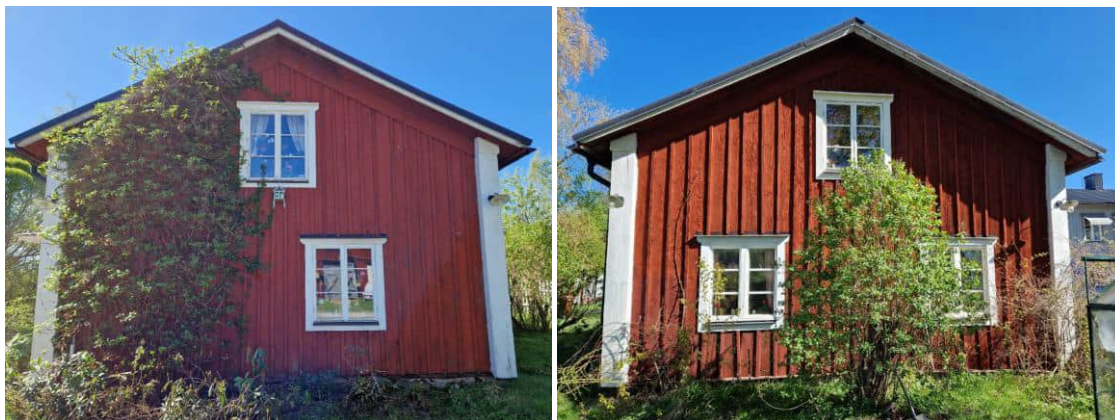
Figur 6. Tv: Fasad mot norr. Th: Fasad mot söder
