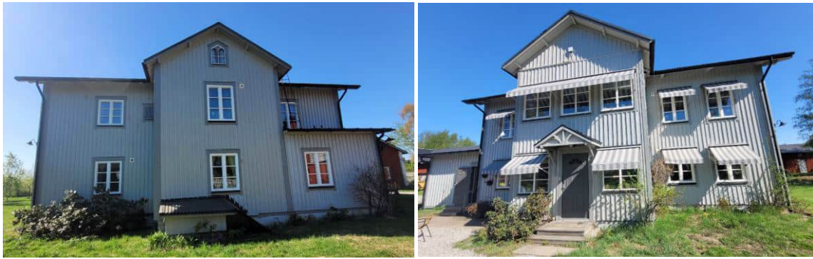
Figur 3. Tv: Fasad mot norr. Th: Fasad mot söder
