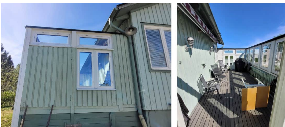
Figur 7 Bullerskyddsskärm vid uteplats på en fastighet i Bredsand.
