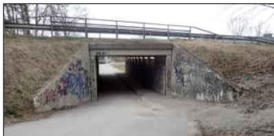
Figur 3.3:7 Elementbyggd bro över gång- och cykelväg vid Kvissleby. Vy mot öster, foto från BaTMan.
