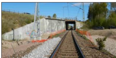
Figur 3.3:6 Bro över järnväg vid Nolby. Vy mot norr, foto från BaTMan.
