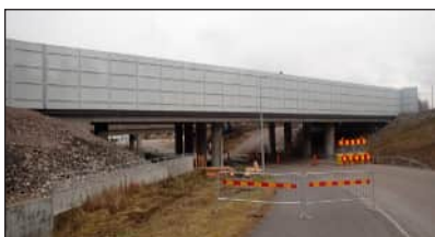
Figur 3.3:16 Bro över Tellusvägen i Bredsand. Vy mot öster, foto från BaTMan.
