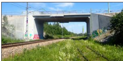
Figur 3.3:14 Bro över järnväg (OKB) och industrispår vid Stockviksverken på rampväg. Vy mot norr, foto från BaTMan.
