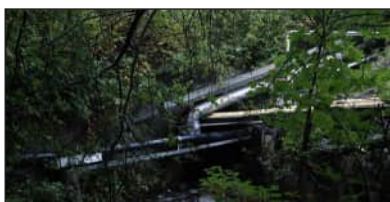
Figur 3.3:12 Vapelbäcken, kulvert. Vy från väster. Foto från BaTMan.
