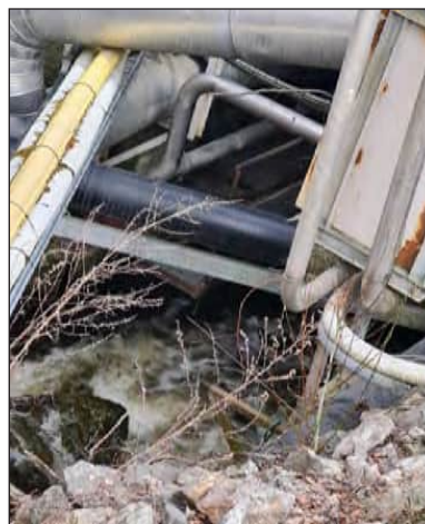
Figur 8.10:7 Vapelbäckens passage under befintlig järnvägsbro. Trycklufts- och gasledning mellan Nouryons två fabriksområden är belägna i bäckens kulvertar.
