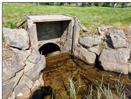
Figur 8.10:14 Spegeldammens utlopp med ett cirka fem decimeter högt fall.
