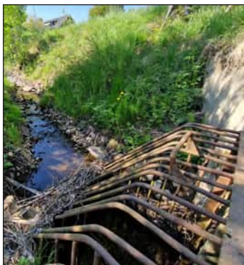
Figur 8.10:3 Tingstagärdesbäckens uppströms trumman. Trummans inlopp täcks av ett galler.
