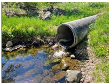
Figur 8.10:15 Den 280 meter långa kulvertens utlopp med ett cirka två decimeter högt stalp.
