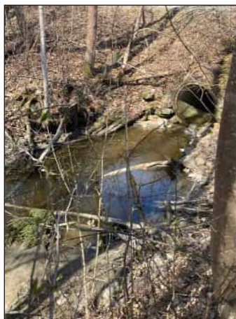
Figur 8.10:4 Nolbybäckens inlopp till kulvert under befintlig järnväg (övre bild). Nolbybäckens nedströms rekreativstråket Strandleden (nedre bild).
