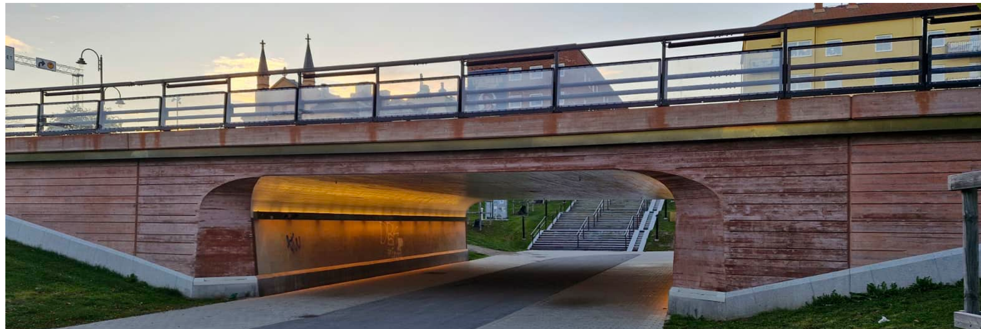
Figur 73. Referensbild för passage under bro med färgad betong.
