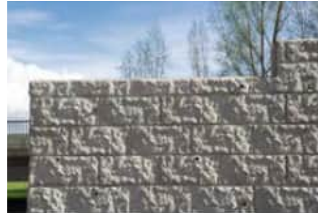
Figur 34. Exempel på mur med matris som efterliknar stora stenar.
