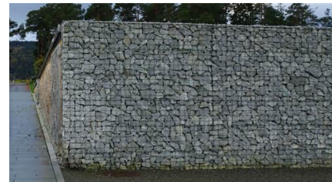
Figur 26. Gabionmur kan vara ett alternativ på stödmur.
