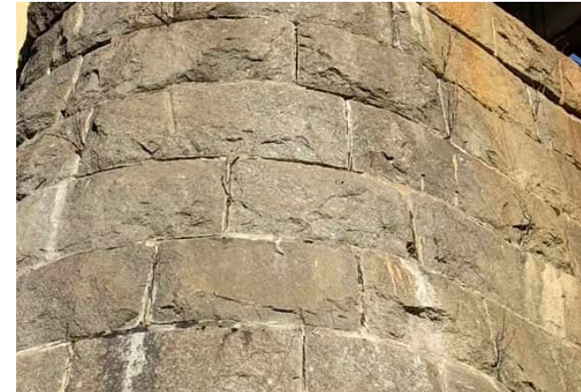
Figur 35. Referensbild på mur vid järnväg med huggen natursten.
