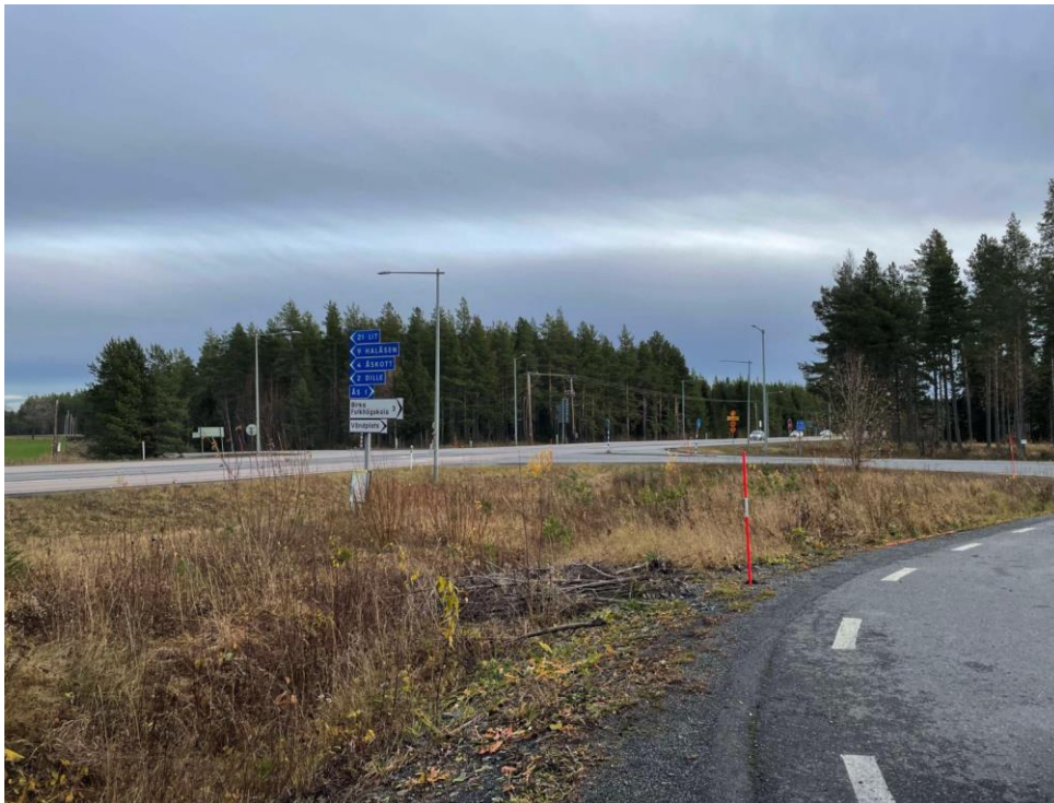
Figur 4.1–1 Befintlig korsning mellan väg E14 och väg 744 i sydöstlig riktning.
