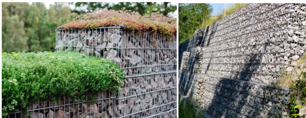
Figur 12 Exempelbild på gabionmurar (källa: gabionersweden.se; tostartp.se)
