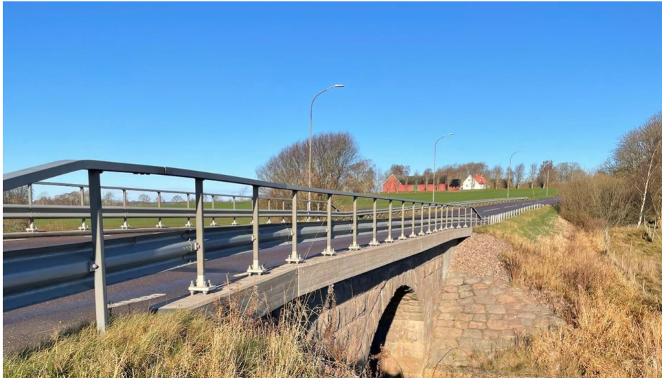
Figur 3. Bild på befintlig valvbro över Suseån.
