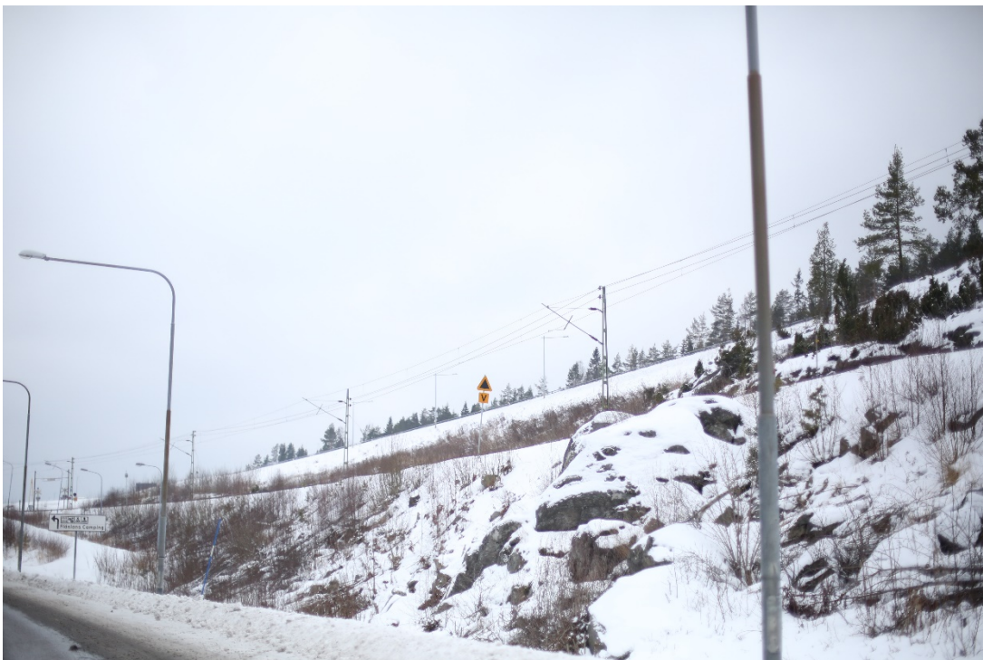
Figur 15. Vid Fläsian är terrängen brant, längst upp i bild syns vägbanken för E4, därpå befintlig järnväg och längst ner väg 562.
