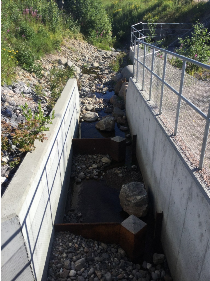
Figur 35. Vandringstrappan i Bredsandsbäcken, vid Tellusvägen.
