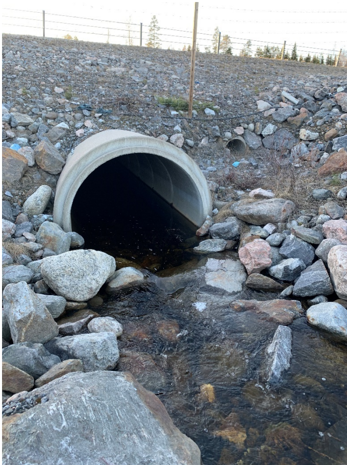
Figur 18. Torrtrumma under E4, den lilla till höger, vid Svarttjärnsbäcken som rinner i den stora trumman.
