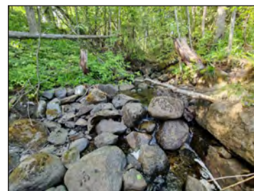
Figur 8.10:12 Brant sträcka uppströms befintlig serviceväg
