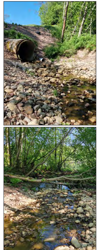
Figur 8.10:2 Tingstagärdesbäcken där den rinner i en kulvert under en promenadstig (övre bild) och vidare mot i Ljungan (nedre bild).
