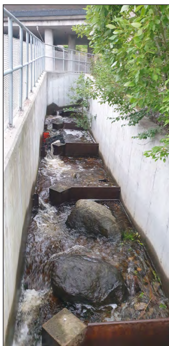
Figur 8.10:19 Fiskvägen under befintlig järnväg.
