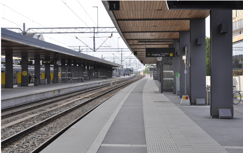
Figur 7 visar spår 1 på Uppsala Centralstation.
