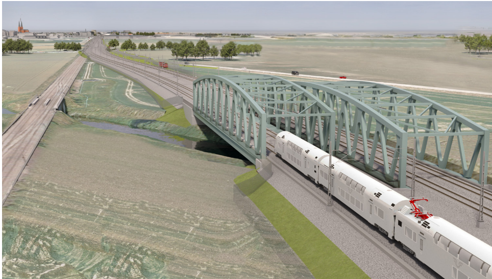
Figur 30 visar de nya spåren och planerad brotyp över Sävjaån. Utformning och gestaltning av broarna kommer studeras vidare.
