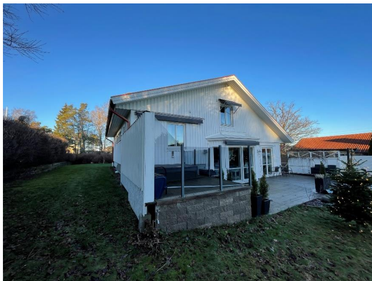
Figur 10. Bostadshuset på fastigheten Bergsbrunna 14:119.
