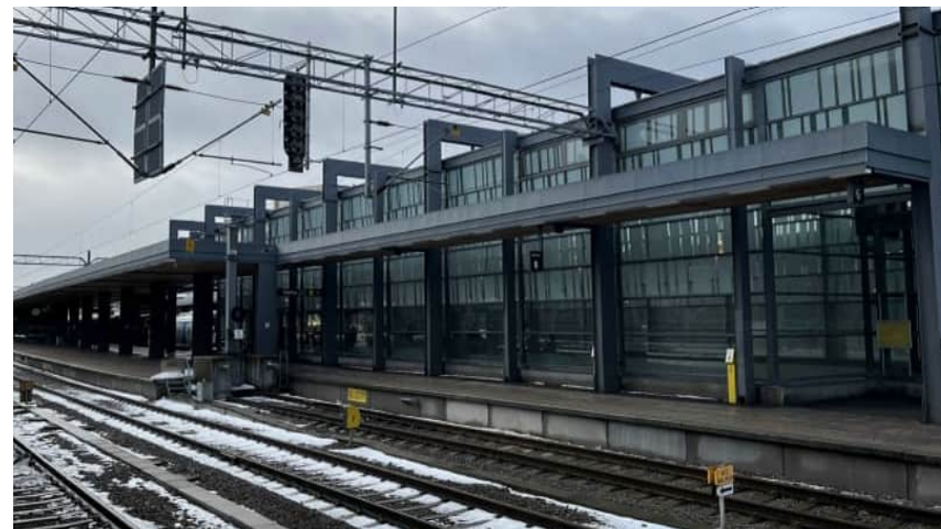
Figur 46. Befintlig plattformsentré med vänthall till spår 2-7.
