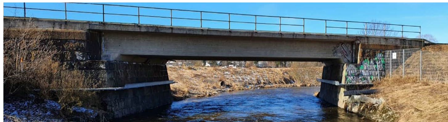
Figur 11. Befintlig bro över Sävjaån.
