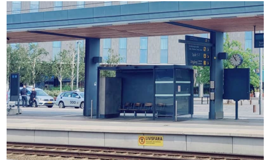
Figur 32. Befintligt väderskydd på Uppsala Centralstation.
