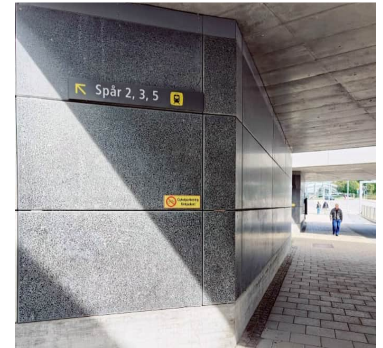
Figur 59. Befintlig passage under Strandbodgatan och anslutning till plattformar. Murbeklädnad av mörk cementmosaik.
