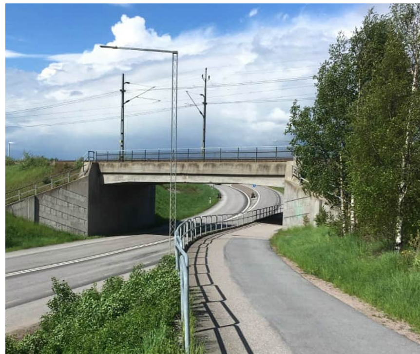
Figur 65. Befintlig järnvägsbro över väg 255. Foto taget från västra sidan av järnvägen.
