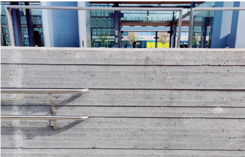
Figur 16. Formsättning av betong på befintlig mur med horisontellt linjemönster och handledare och lågt räcke på murkrönet, Uppsala Centralstation, spår 1.
