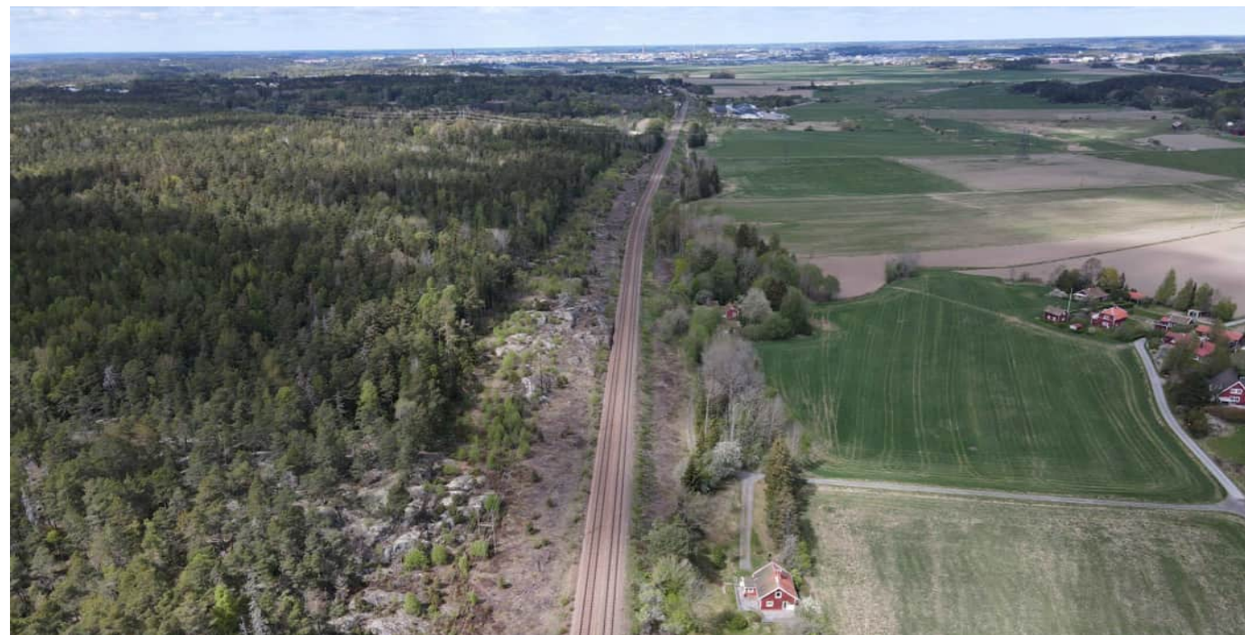
Figur 68. Vy åt norr över delområde där Uppsala Södra i framtiden kommer att utvecklas.
