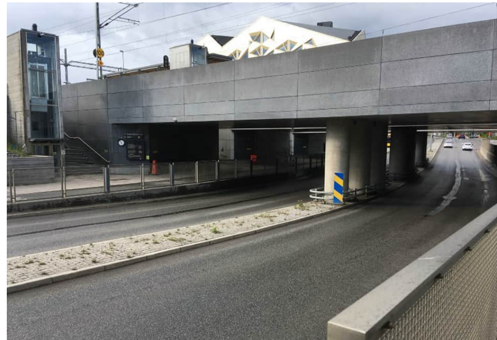
Figur 58. Befintlig järnvägsbro över Strandbodgatan, västra sidan.
