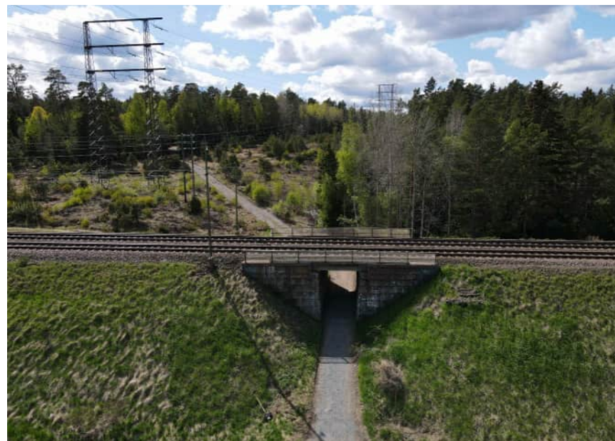
Figur 73. Befintlig järnvägsbro, Vallby vägport.
